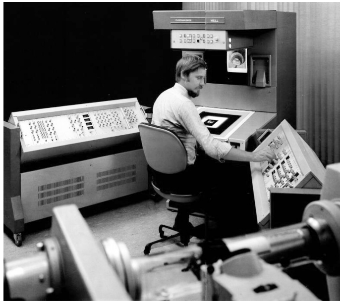
Рис. 4. Оператор устанавливает коэффициенты цветоделения на пульте управления ЭЦК Хромограф, поместив слайд-оригинал перед передающей камерой одной из первых систем «видеопробы» Хромаскоп фирмы Р. Хелль, 1974 г.
