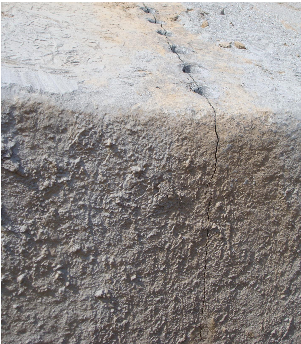
Рис. 4. 21. Завершення тріщиноутворення по всій площині розколювання блоку №2 (гідропоршневі агрегати витягнуті зі шпурів).
