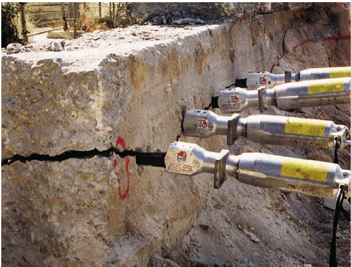
Рис. 1.5. Розколювання бетонного блоку за допомогою гідравлічних клинів.
