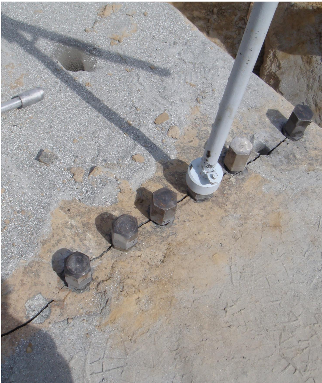
Рис. 4.20. Розширення тріщини розколювання в блоці №2.
