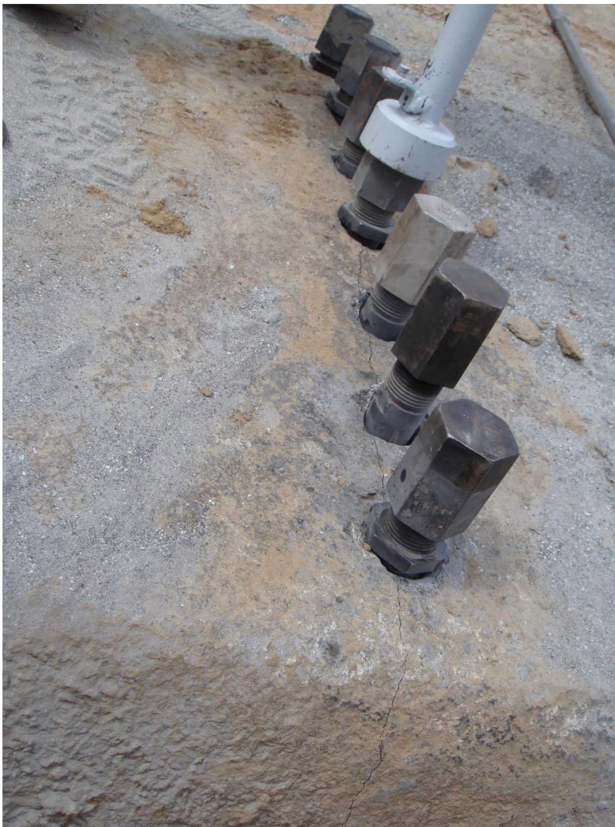
Рис. 4.19. Тріщиноутворення в блоці №2.
