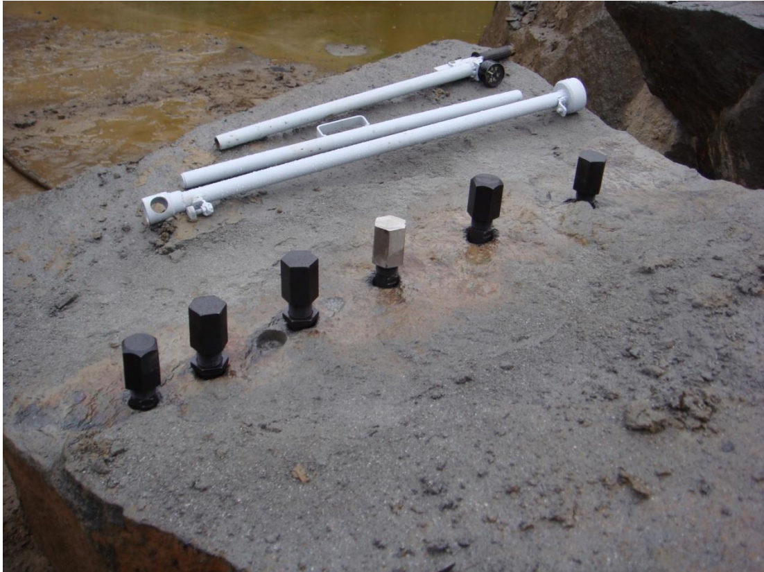
Рис. 4.12. Встановлення гідропоршневих агрегатів в шпура блоку №1 (на задньому плані тарувальний гайковий ключ з месдозою).
