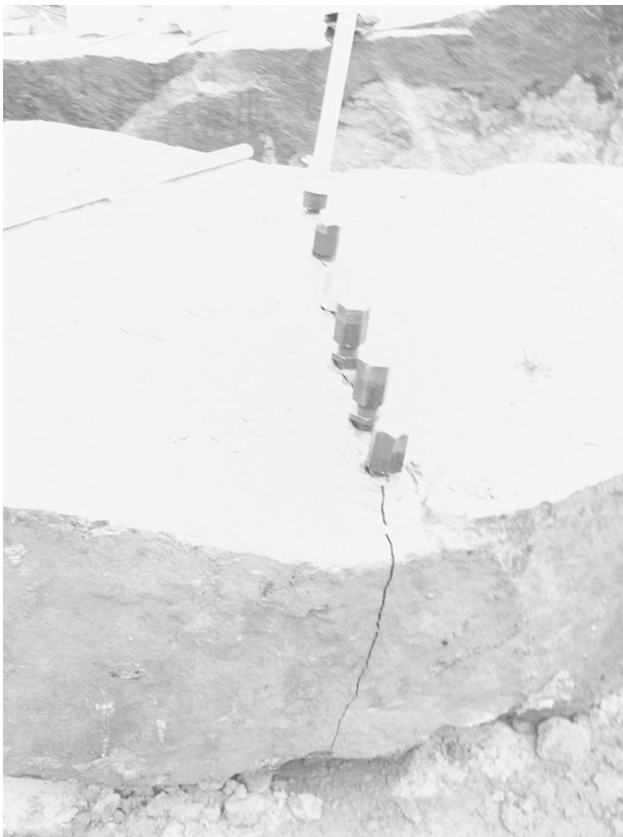
Рис. 4.14. Завершення тріщиноутворення по всій площині розколювання блоку №1.
