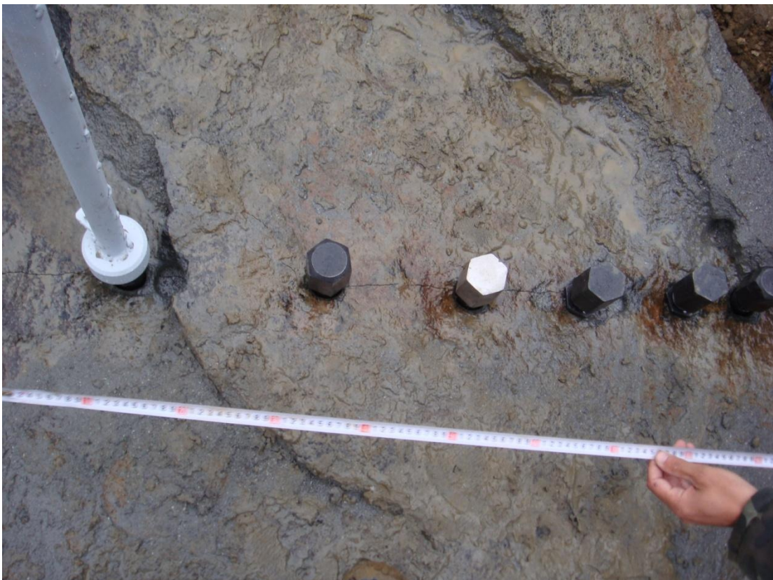
Рис. 4.13. Тріщиноутворення в блоці №1.
