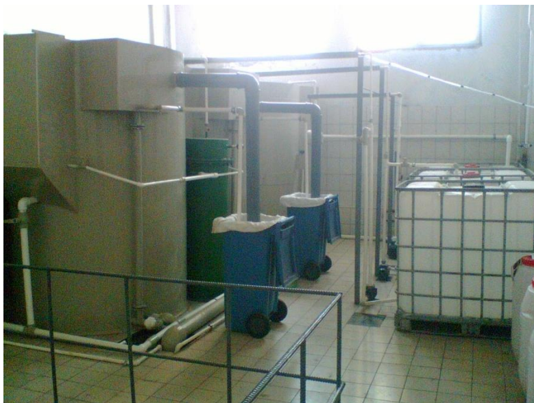
Рисунок 2.6 – Фото системи очищення концентрованих стічних вод гальванічного виробництва ТзОВ «Брополь»
