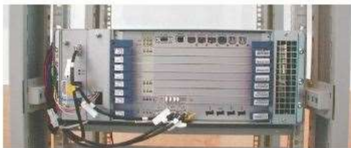
Рисунок А.3 – Зовнішній вигляд базової станції "Ericsson RBS 3418"
