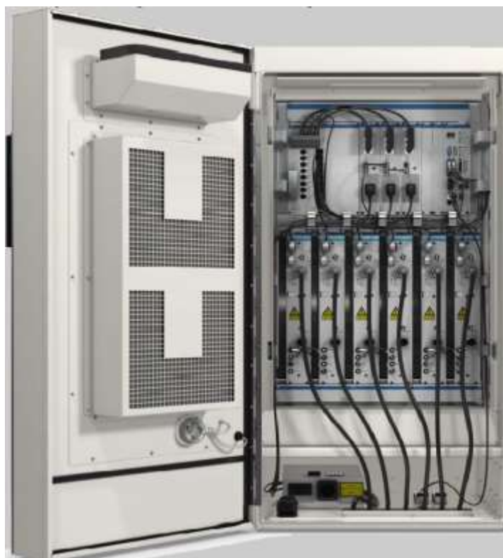
Рисунок А.1 – Зовнішній вигляд базової станції "Ericsson RBS 2116"
