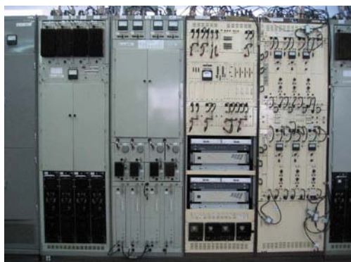
Макет інтегрованого формувача, вмонтований у стійку радіорелейного обладнання «Курс-4»
