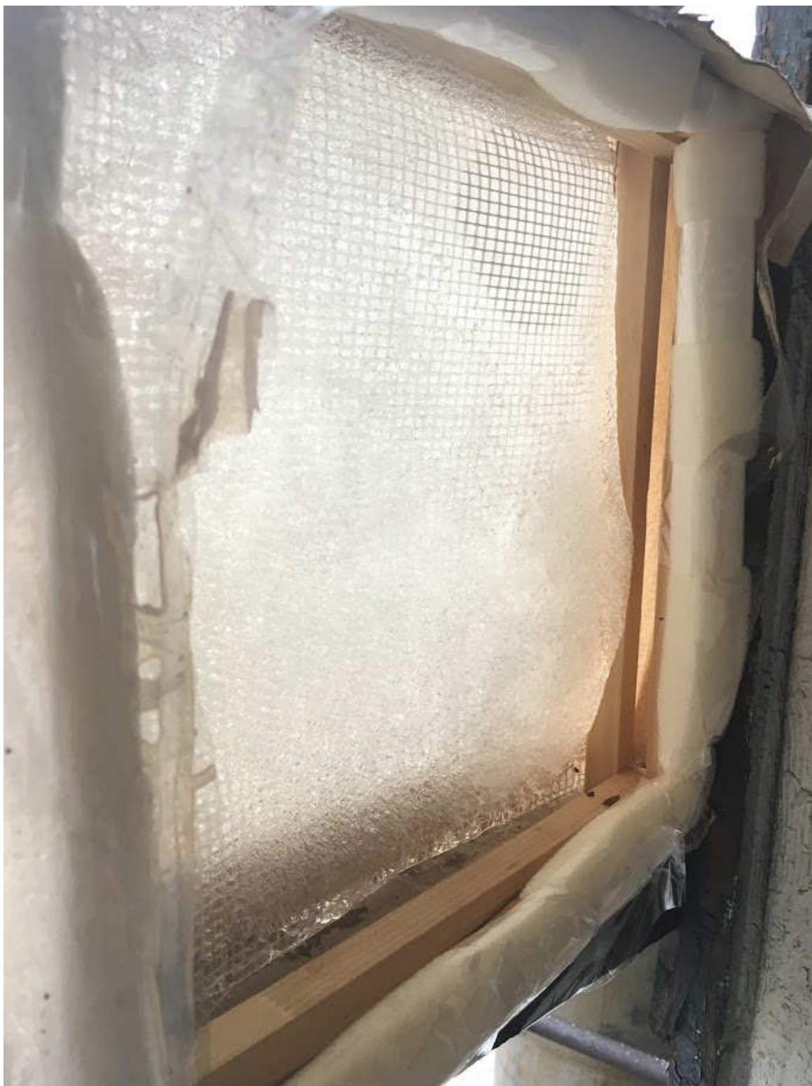
Рисунок 2.19 - Подвійна льодяна конструкція
