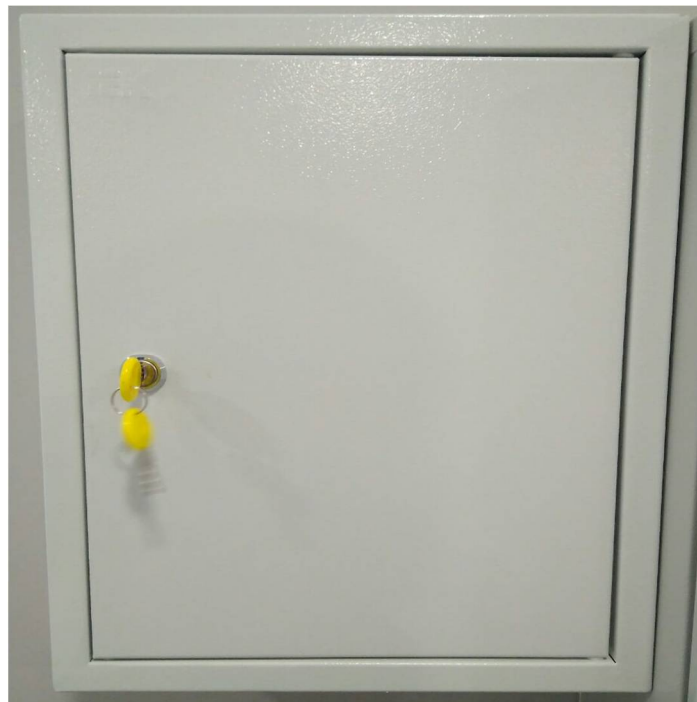
Рис.2.7(а). Загальний вигляд щитка живлення.
