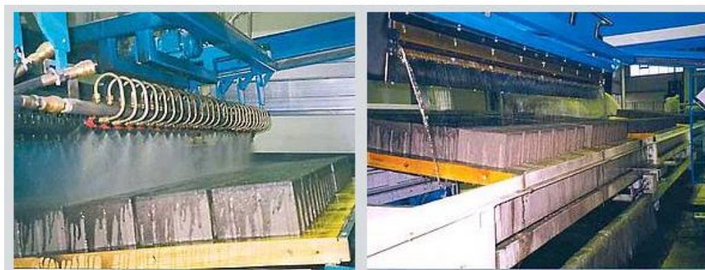
Рис 3. Установка для обробки бетону способом «миття» верхньої поверхні
