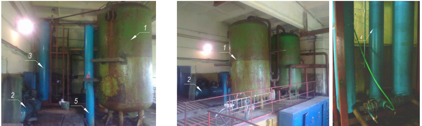
Рис. 6.32. Загальний вигляд фільтрувального залу станції знезалізнення після реконструкції: 1 – напірні фільтри; 2 – компресор; 3 – колони змішувачі-деаератори; 4 – колона постійного рівня із підведенням розчину натрію гіпохлориту; 5 – колона відведення відпрацьованих промивних вод
