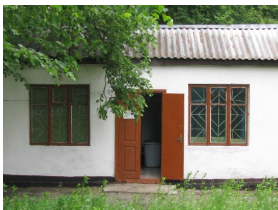
Рис. 6.34. Зовнішній вигляд існуючої станції знезалізнення в м. Корець
