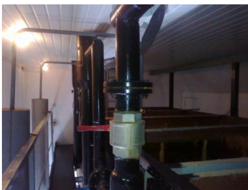
Рис. 6.16. Фільтрувальний зал станції
