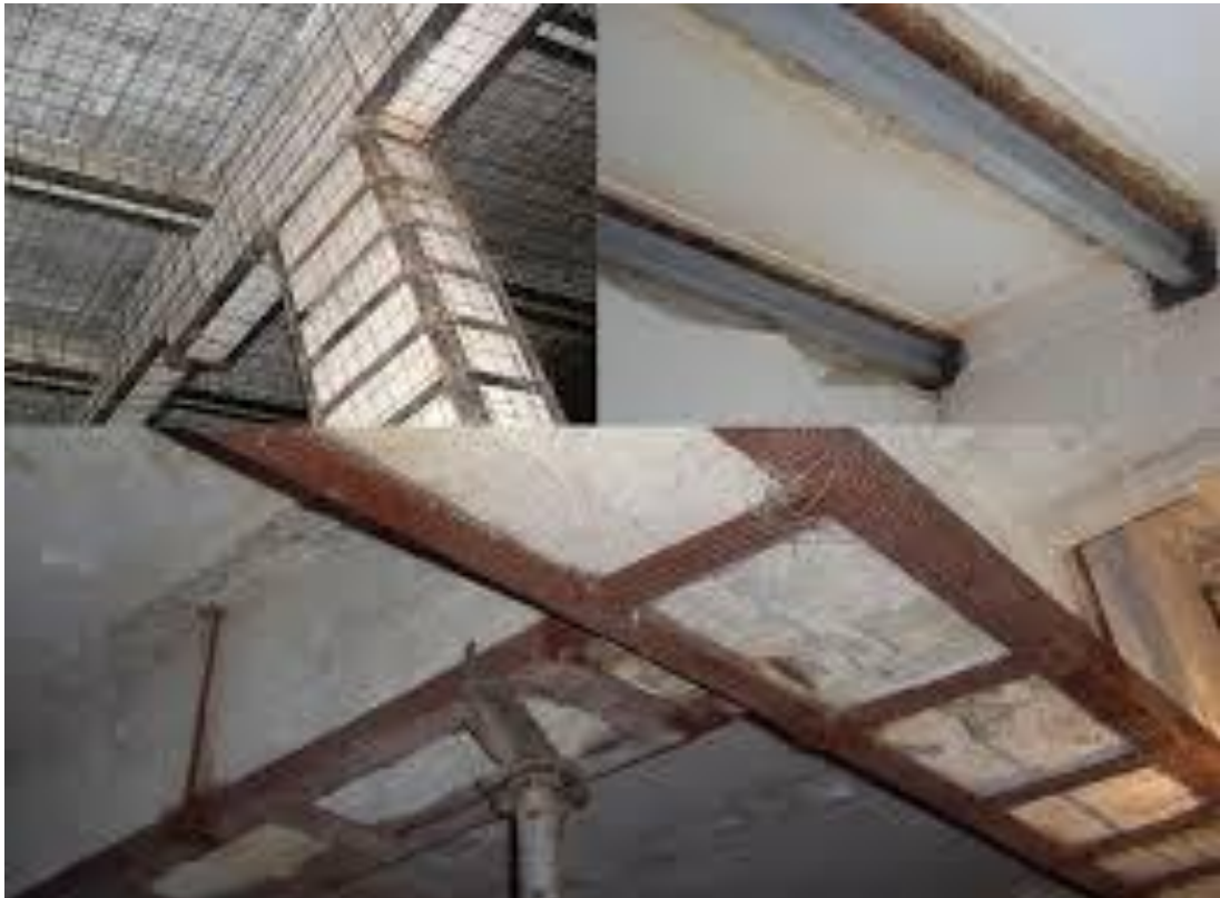
Рис.4.1. Загальний вигляд підсилення ригеля
