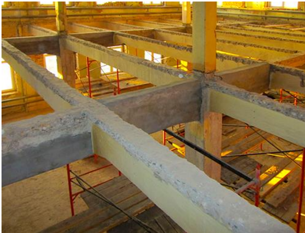
Рис. 2.1. Загальний вигляд каркаса будівлі
