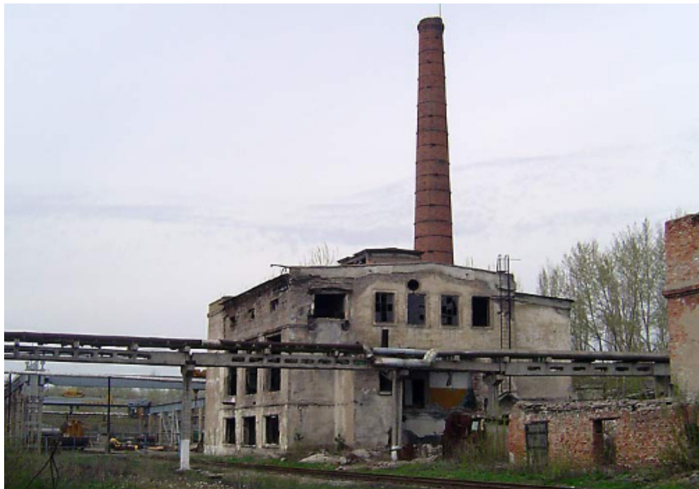
Рисунок 1.1 – Зовнішній вигляд котельні по вул. Довга, 68 в м. Івано-Франківськ
