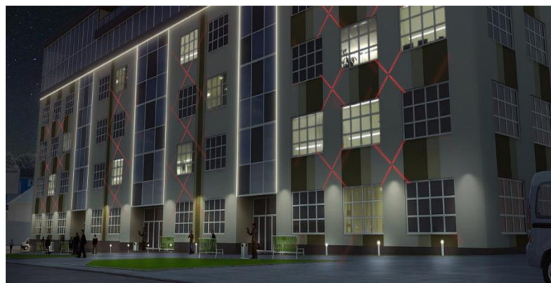
Рис. 1.6 Приклад художнього підсвічування фасаду будівлі
