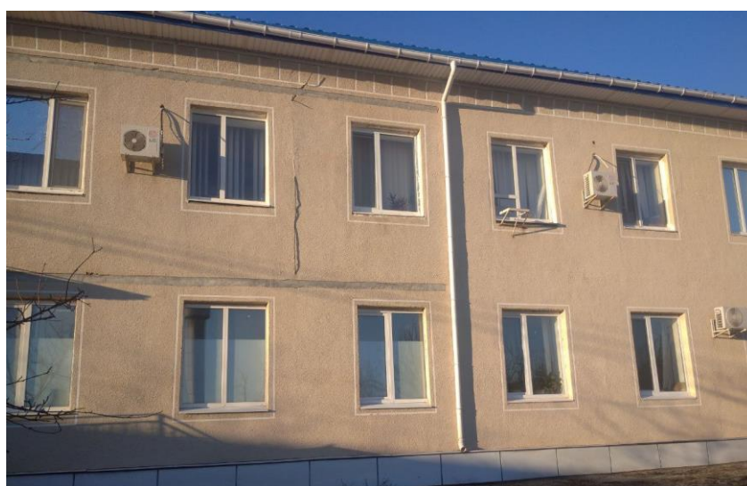
Рисунок 3.2 – Східний фасад адміністративної будівлі Новоархангельських ЕМ
