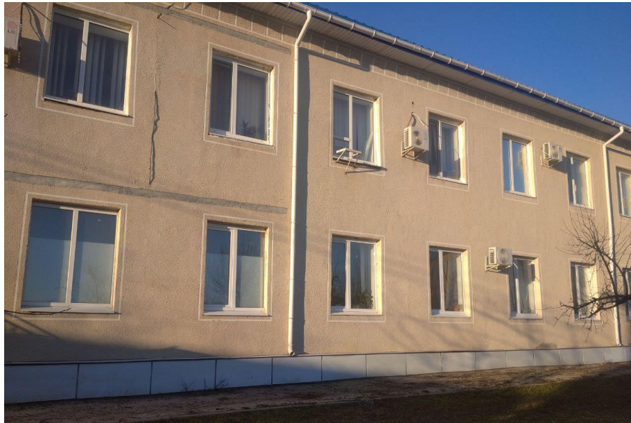
Рисунок 1.2 – Зображення будівлі Новоархангельських ЕМ
