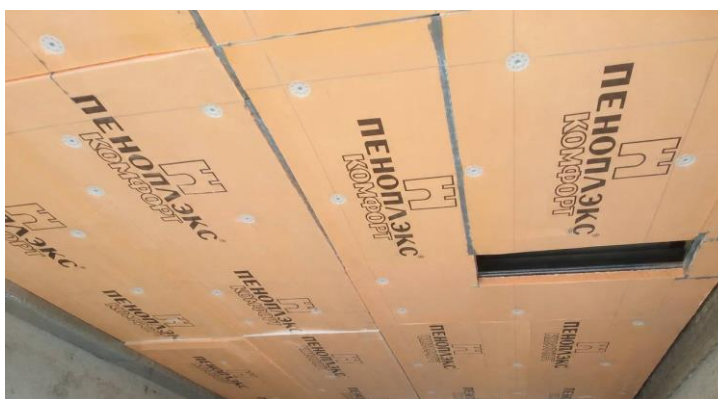
Рисунок 3.6 – Утеплення перекриття неопалювального підвалу
