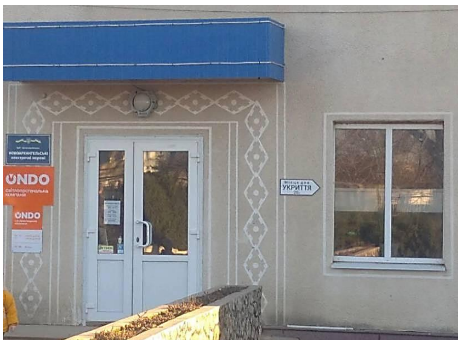
Рисунок 1.3 – Світлопрозорі огорожувальні конструкції в адміністративній будівлі
