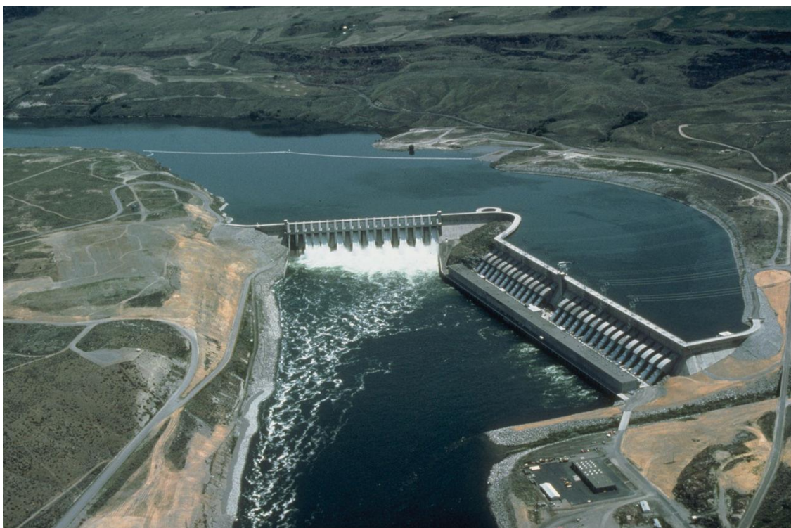
Рисунок 1.3 – Приклад ГЕС руслового типу – ГЕС Вождя Джозефа, Бріджпорт, Вашингтон [2]
