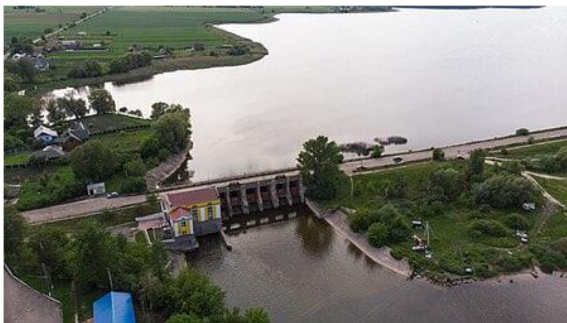
Рисунок 1.5 – Приклад пригреблевої ГЕС – Хрінницька ГЕС, р. Стир, встановлена потужність 0,9 МВт [3]
