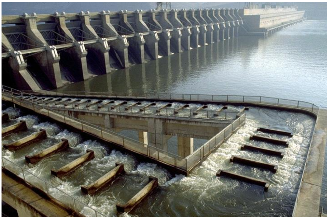
Рисунок 1.8 – Рибохід на греблі на річці Джон-Дей, США [7]
