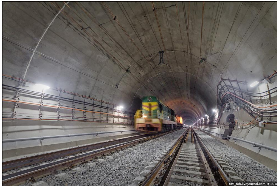
Рис. 2.5. Залізобетонна обробка тунелю
