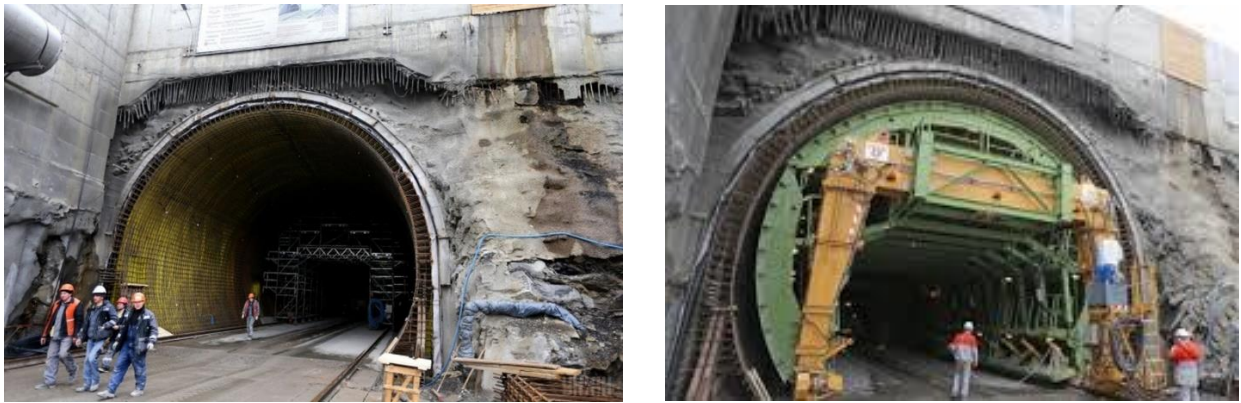
Рис. 2.7. Арматурний просторовий каркас
