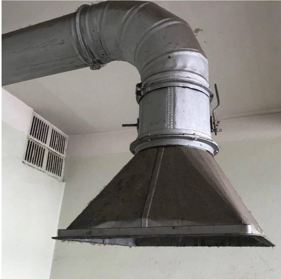
Рисунок 5.2 – Витяжна вентиляція марки С5.45-3.0
