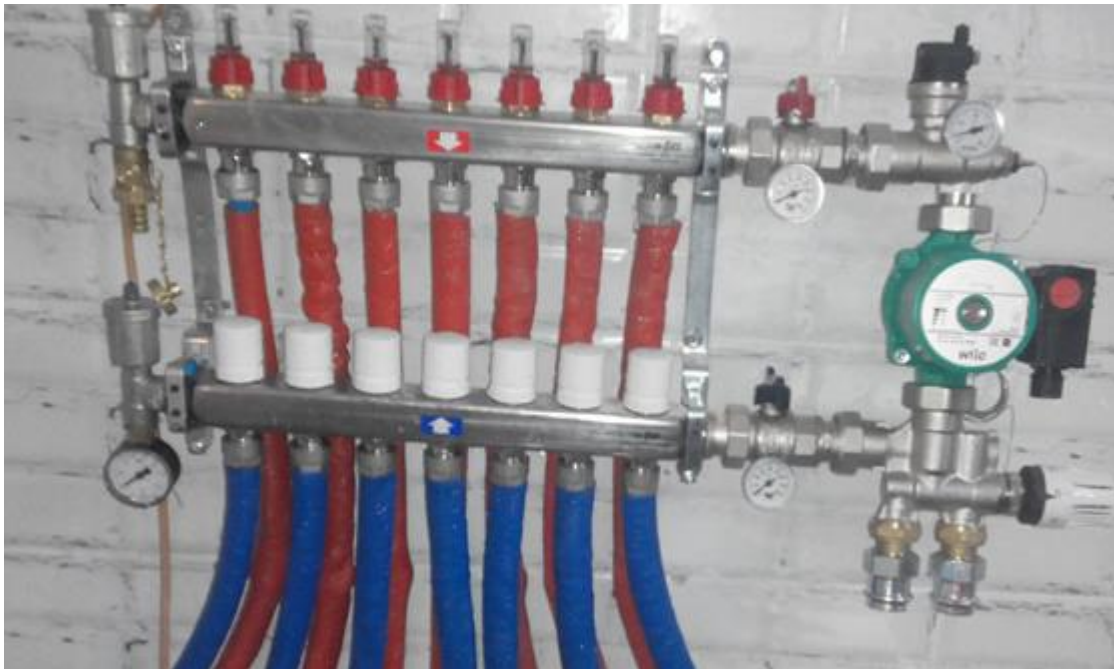
Рисунок 6.4 - Компонівка колекторів для системи «тепла підлога»
