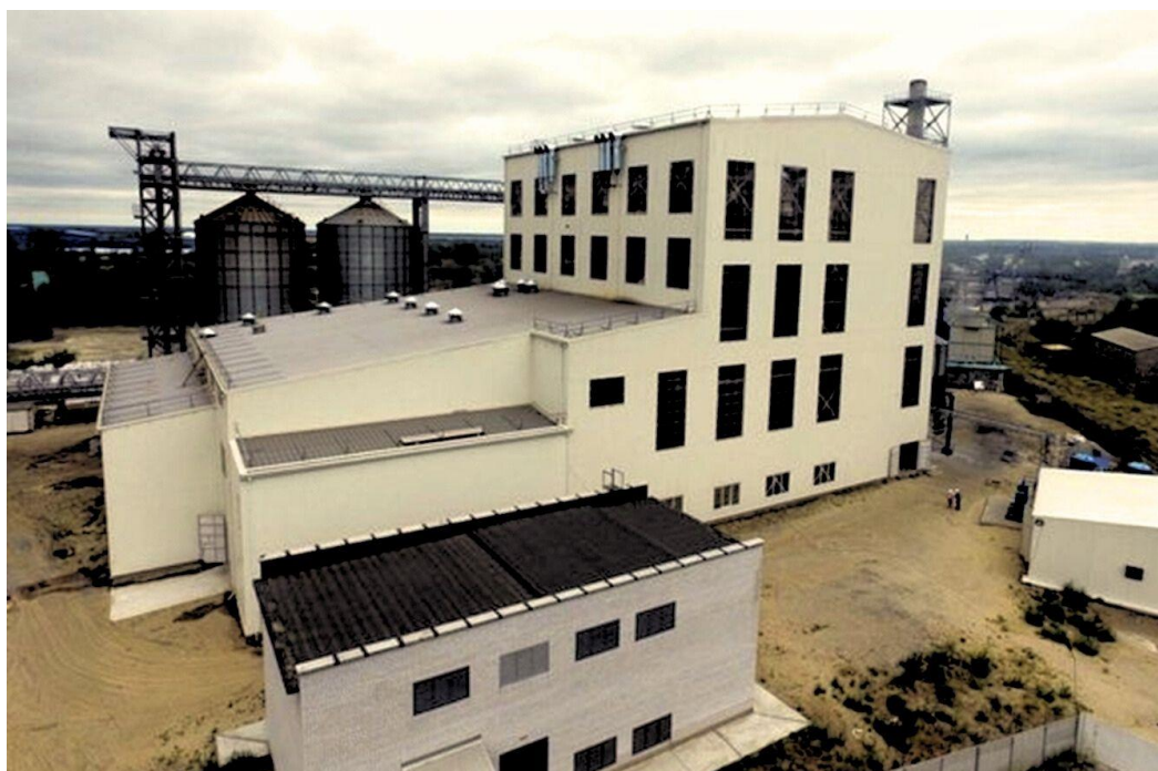
Рисунок 2.1 – Загальний вигляд ТЕС на біопаливі «Аякс-Дніпро»
