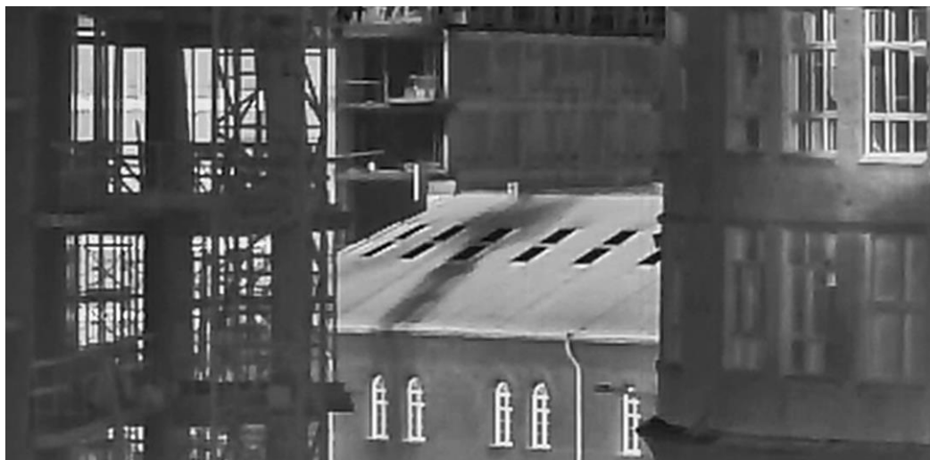
Рисунок 3.5.2 приклад кадру зробленого на поляриметричний тепловізор з поворотною поляриметричною пластиною на практиці в КБ СПБ “АРСЕНАЛ”
