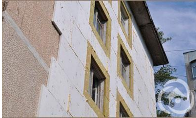
Рисунок 3.3 – приклад утеплення стін
