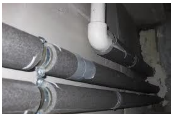
Рисунок 3.6 – приклад ізоляції трубопроводів
