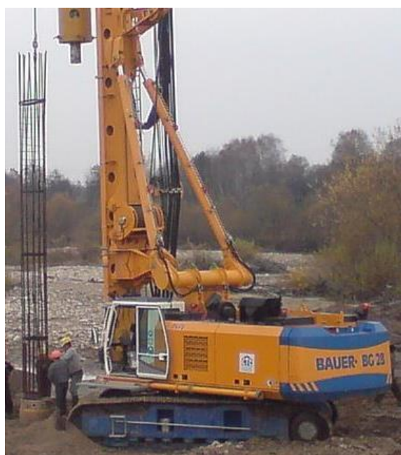
Рисунок 5.2 – Занурення у свердловину просторового арматурного каркасу
