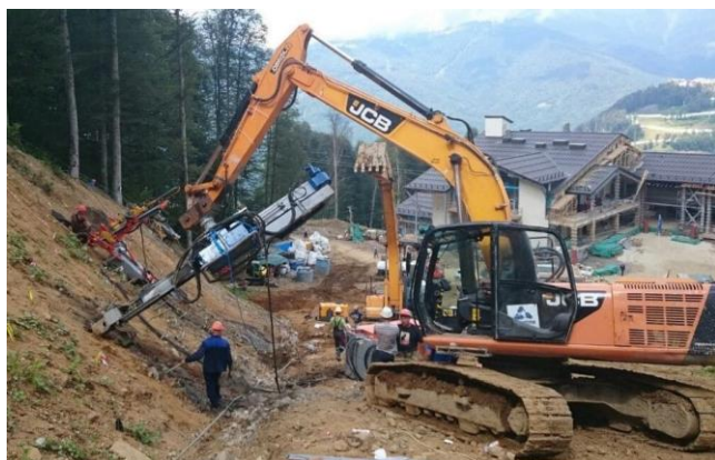
Рисунок 5.6 – Бурові установки для влаштування ґрунтових анкерів
