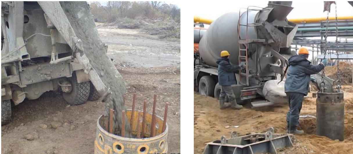
Рисунок 5.3 – Заповнення бетоном свердловини з арматурним каркасом
