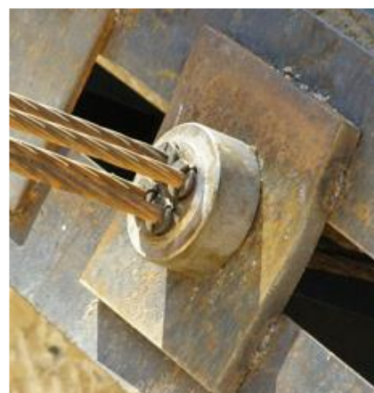
Рисунок 5.8 – Закріплення ґрунтового анкера в свердловині
