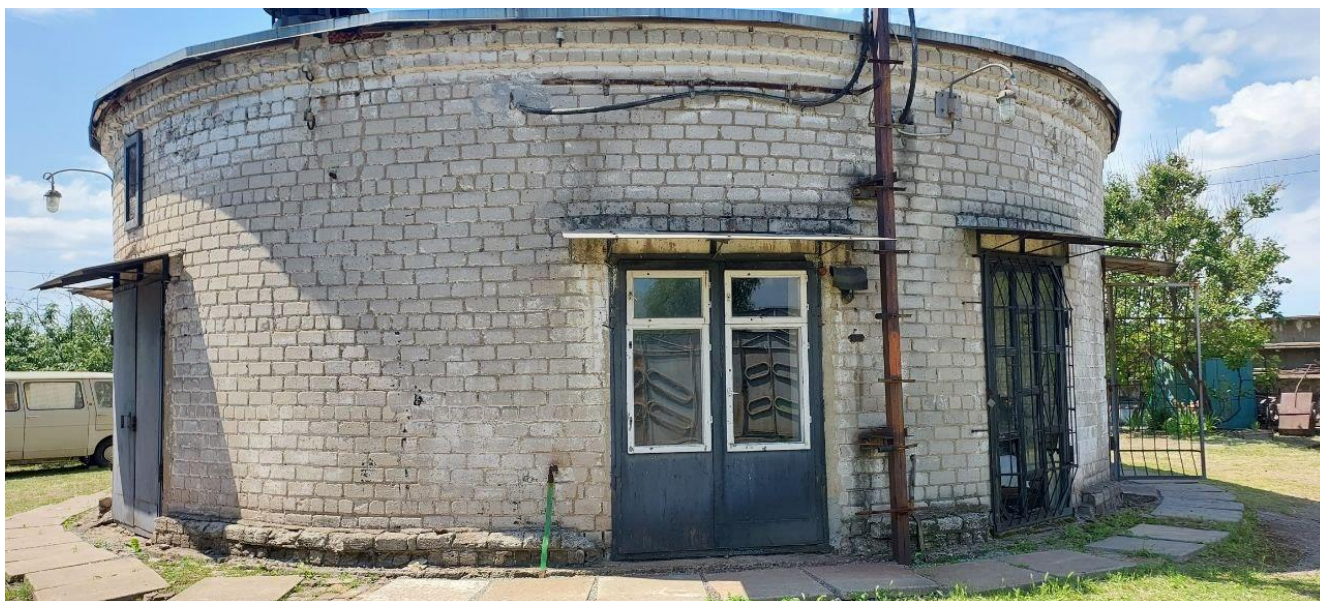
Рисунок 1.1 – Будівля каналізаційної насосної станції
