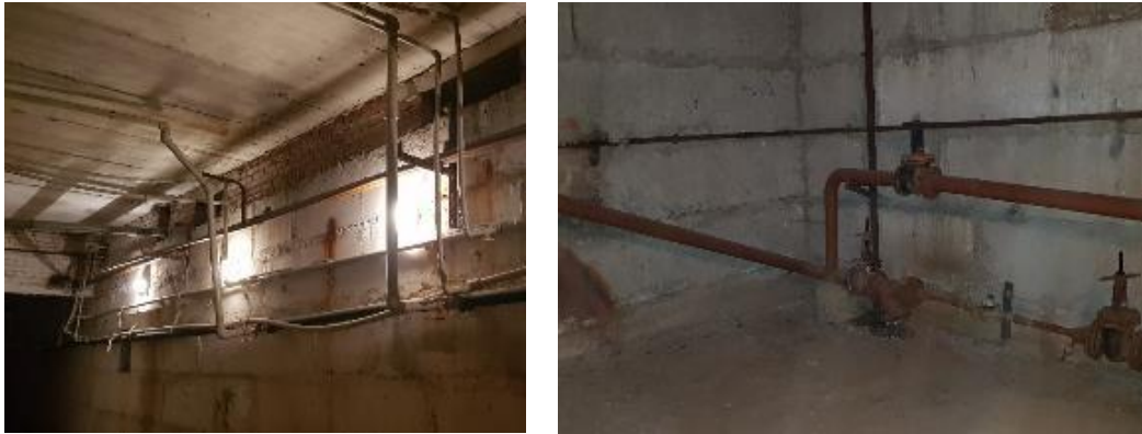
Рисунок 3.4 – Загальний вигляд підвалу лікарні
