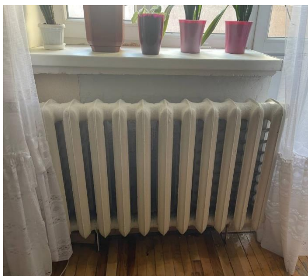
Рисунок 2.3 – Зовнішній стан опалювальних чавунних батарей (в кімнатах та на коридорах)
