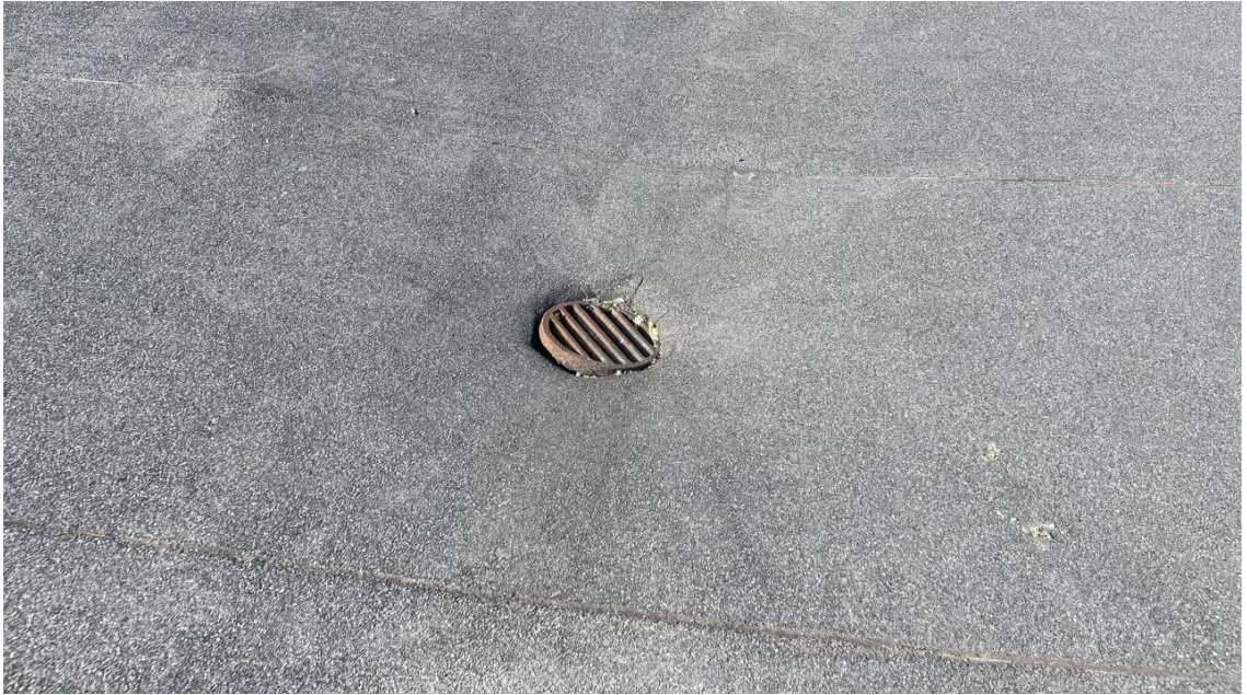
Рисунок 2.14 – Зовнішній вигляд даху будівлі та стічних каналів
