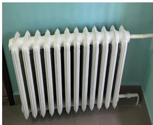
Рисунок 2.3 – Зовнішній стан опалювальних чавунних батарей (в кімнатах та на коридорах)
