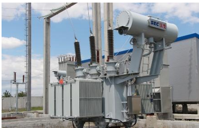
Рисунок 1.5 – ПС 110/20 кВ «Калюсик» в Хмельницькій області
