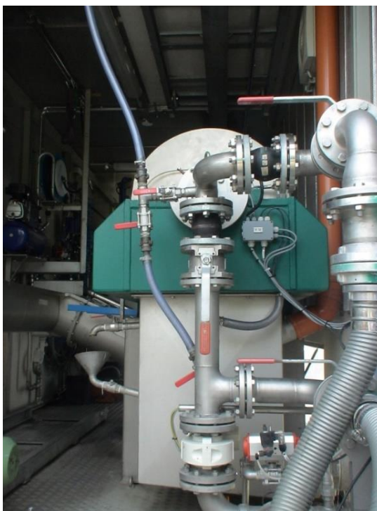
Рисунок 3.10 – Відцентровий декантер UCF 466-00-35
