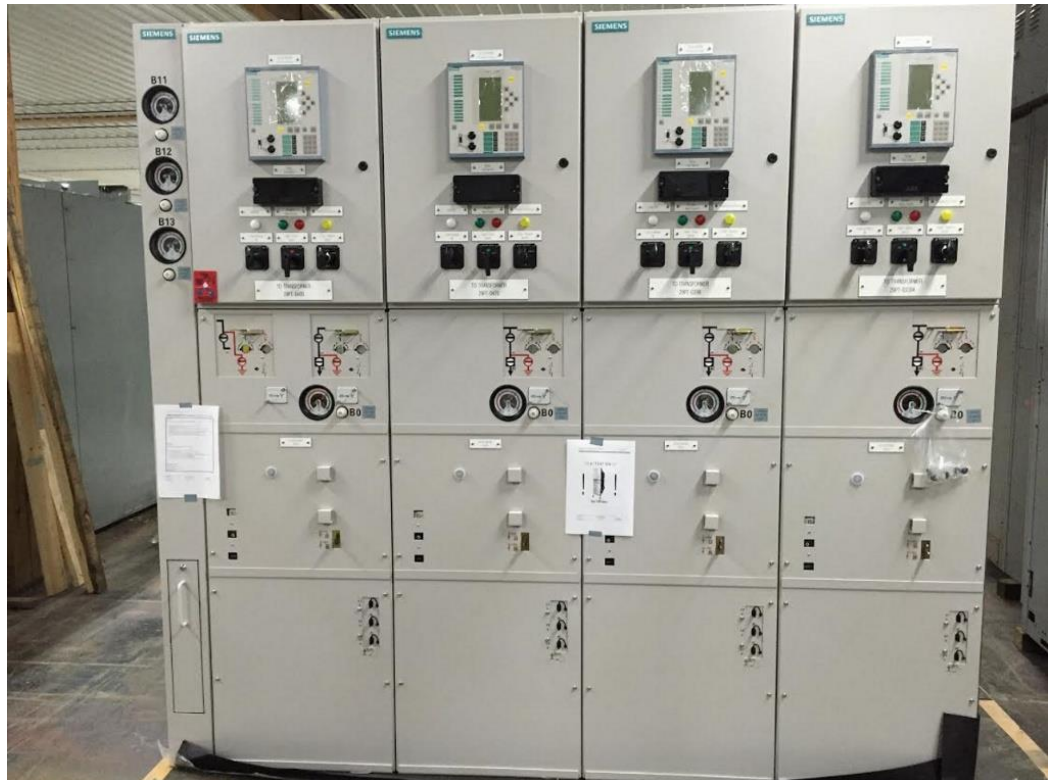
Рисунок 5.3 Комірки 8DA 1250A 38кВ
