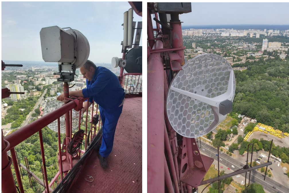
Рисунок 3.20 - Встановлення і юстування антени на сайті А (Дорогожицька телевежа)
