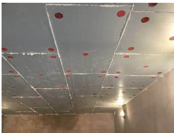
Рисунок 3.3 – Утеплення перекриття підвалу
