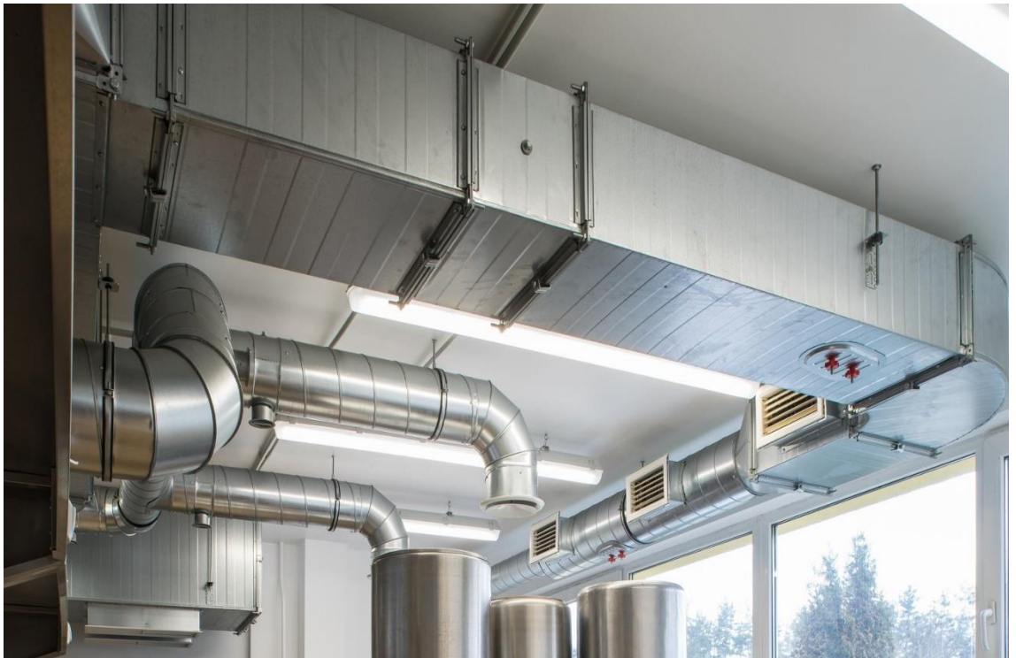
Рисунок 2.10 - Конструкція повітроводів
