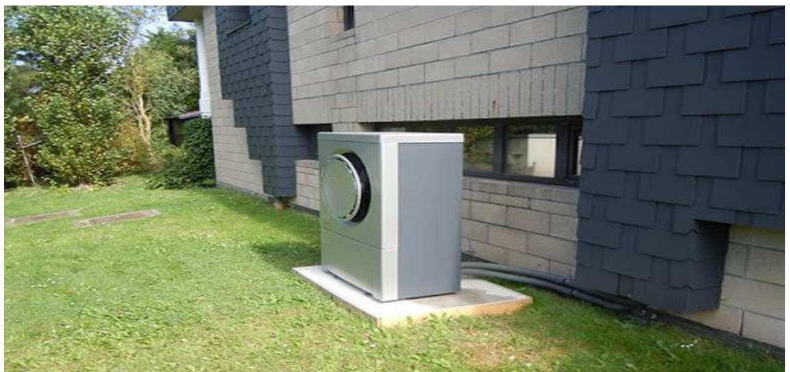
Рисунок 2.8 - Загальний вигляд зовнішнього блоку теплового насоса системи «повітря-повітря»
