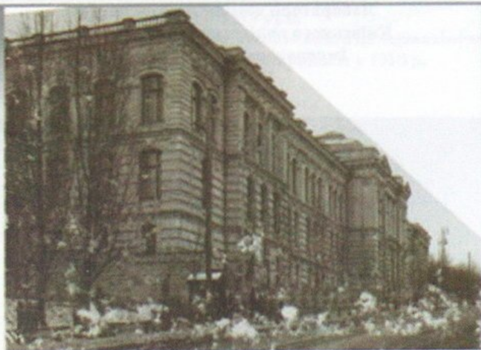
Київське Комерційне училище по вул. Бульваро-Кудрявській – перше приміщення Київського політехнічного інституту Імператора Олександра II (1898–1899 рр.)
