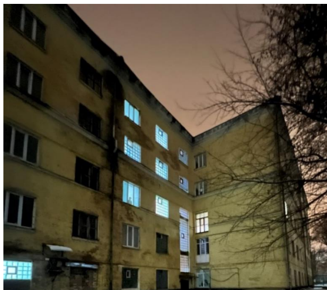
Рисунок.2.2 – Зовнішній вигляд задньої частини будівлі
