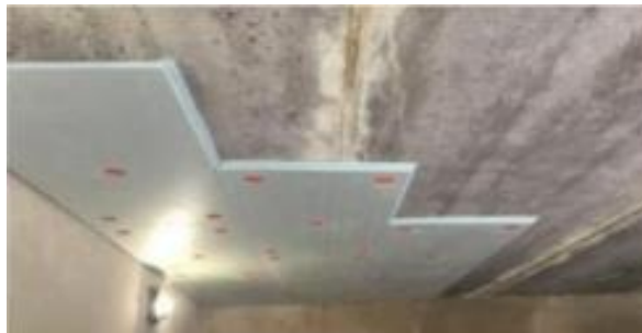
Рисунок 4.4 – Фото-приклад утеплення переkritтя підлоги
