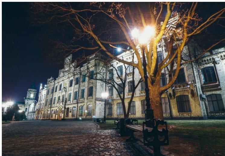
Рис. 1.10 Освітлення фасаду першого корпусу КІІ ім.Ігоря Сікорського
