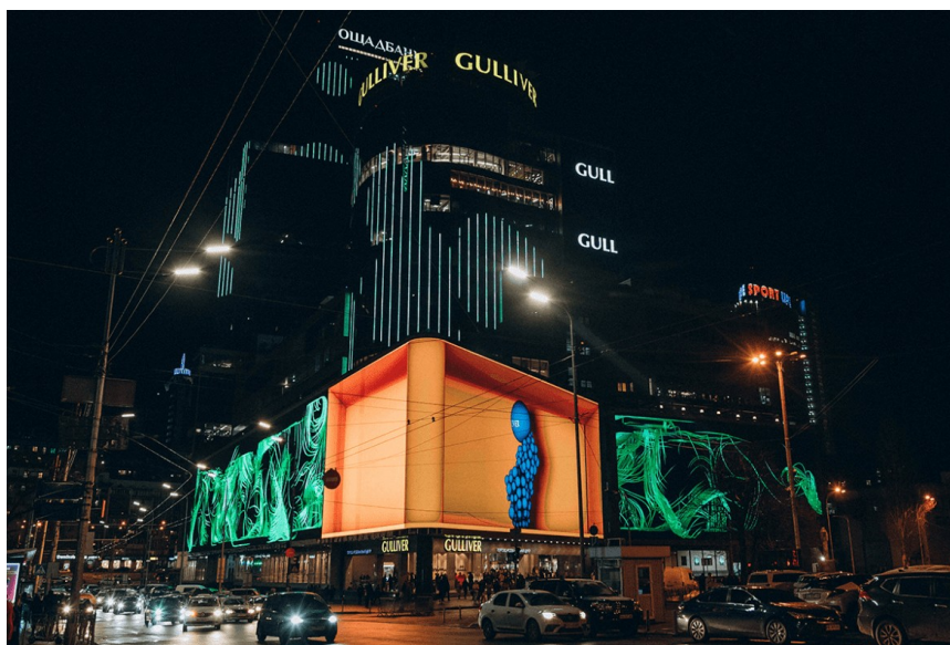
Рис.1.7 Медіафасад ТРЦ Гулівер м.Київ
