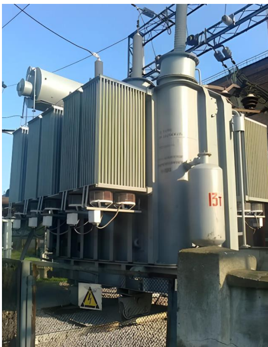
Рисунок 1.3 – Трансформатор ТРДН-40000/110
