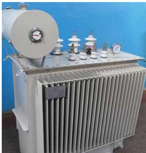
Рисунок 1.8 – Трансформатор власних потреб ТМ-630/10
