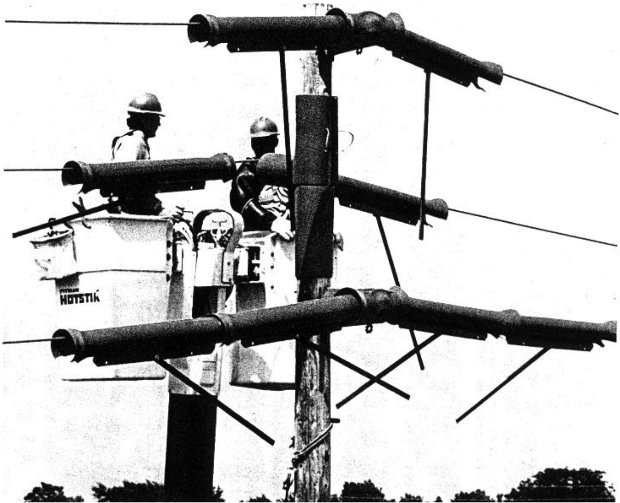
Рис. 1.1. Обслуговування ПЛ за методом «гумових рукавиць»
