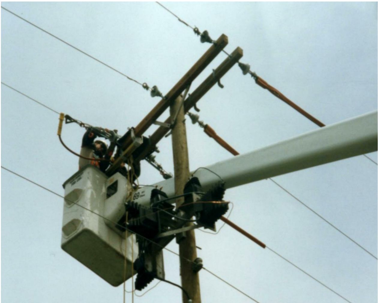
Рис. 2.8. Загальний вид обслуговування ПЛ під робочою напругою із застосуванням рукавичного методу
