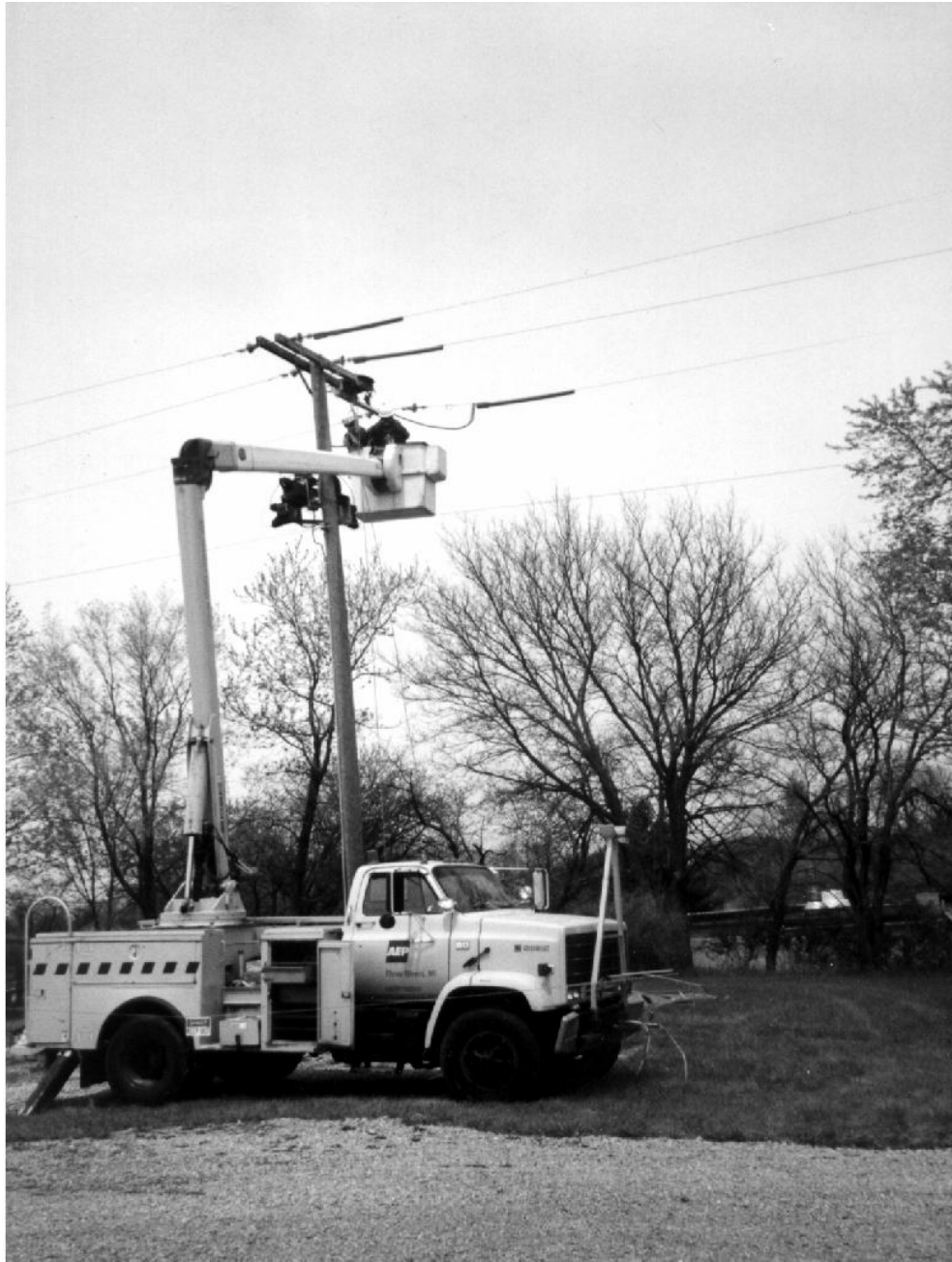
Рис. 1.2. Приклад проведення робіт ПРН в розподільних електричних мережах
