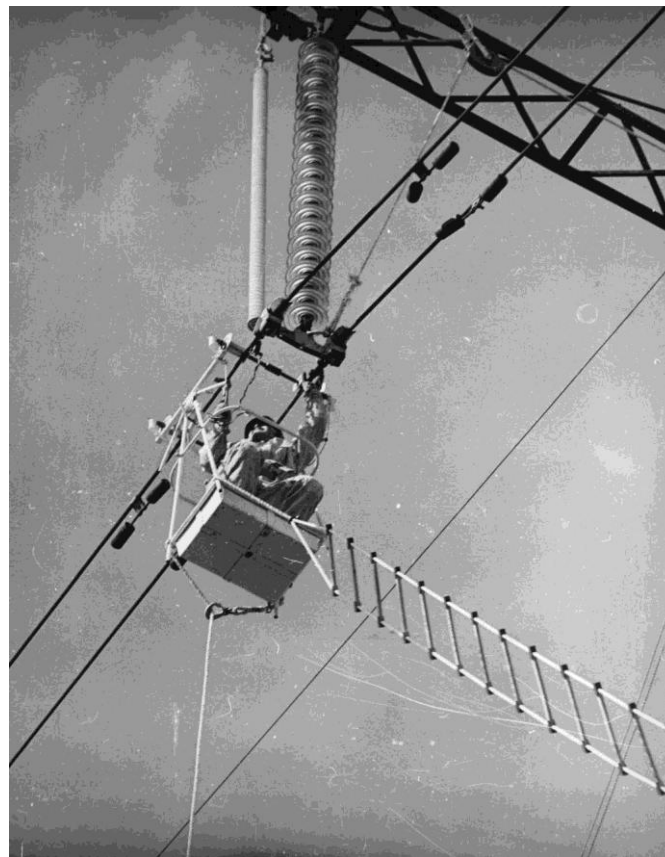
Рис. 4.31. Монтаж стільця-візка на проводах після його підйому
