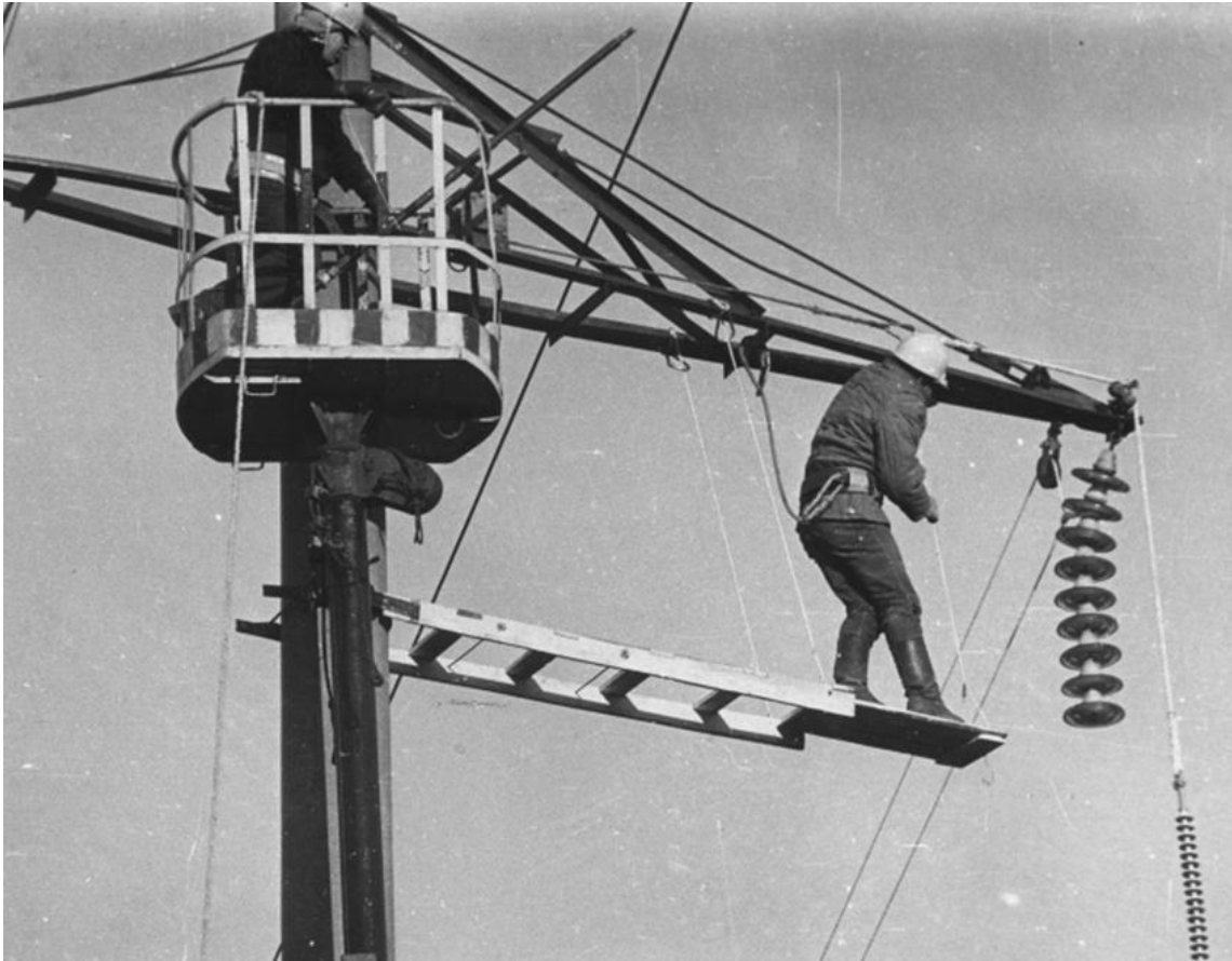
Рис. 4.21. Використання навісного трапу під час ремонту гірлянди ізоляторів на ПЛ 110 кВ
