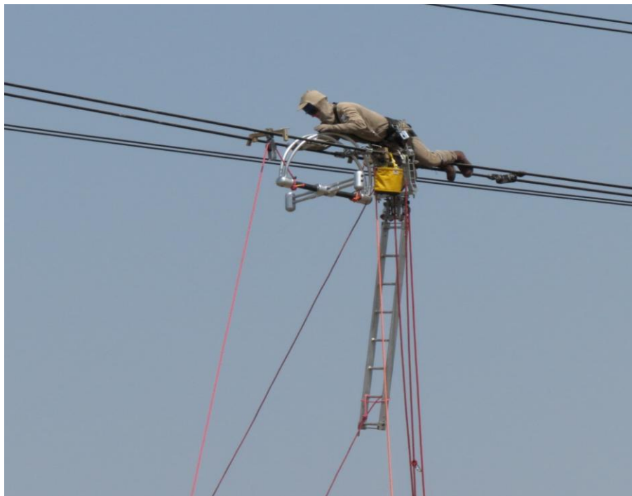
Рис. 4.34. Доставка електромонтера на місце роботи
