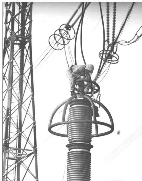
Рис. 4.40. Виконання робіт під напругою на ошиновці та верхівці трансформатора напруги 750 кВ
