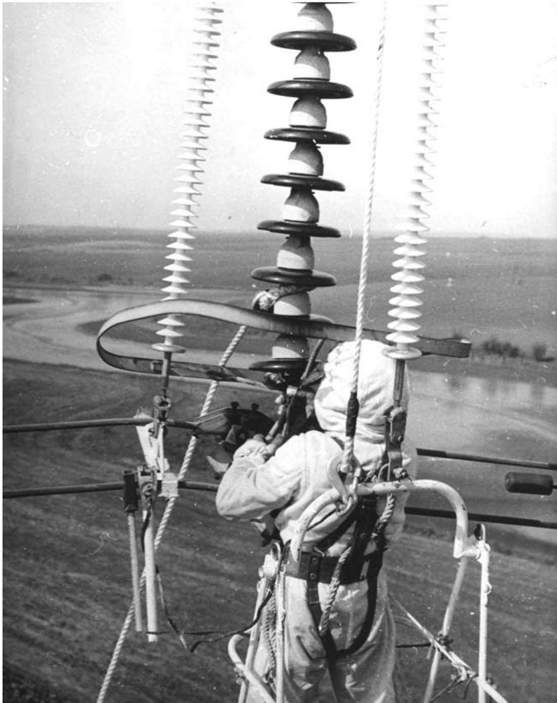
Рис. 4.25. Робота на потенціалі у монтерському стільці
