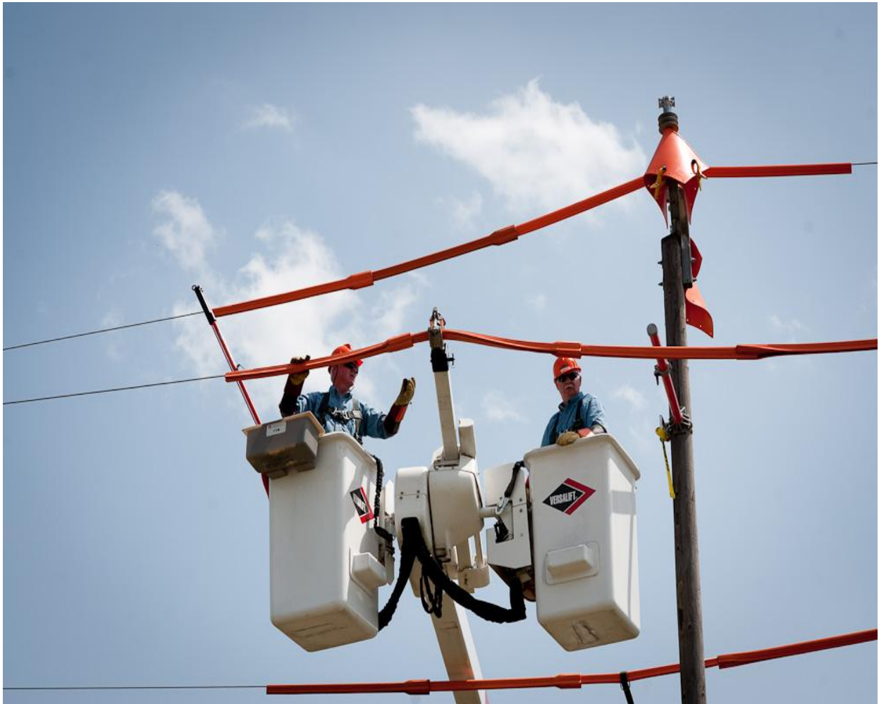
Рис. 3.5. Монтаж обладнання на ПЛ під напругою
