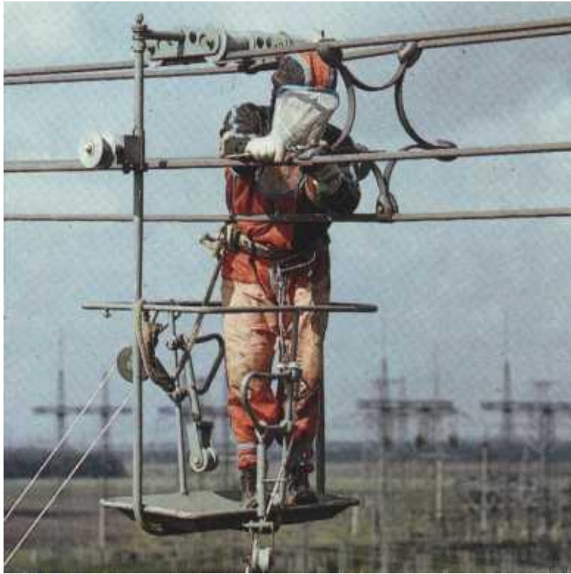
Рис. 4.32. Переміщення візка з електромонтером по проводах під час ревізії та ремонту розпірок
