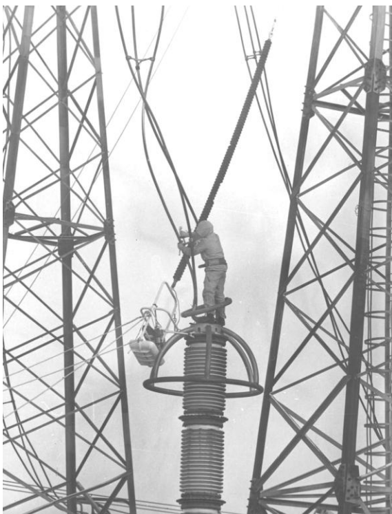
Рис. 4.40. Виконання робіт під напругою на ошиновці та верхівці трансформатора напруги 750 кВ
