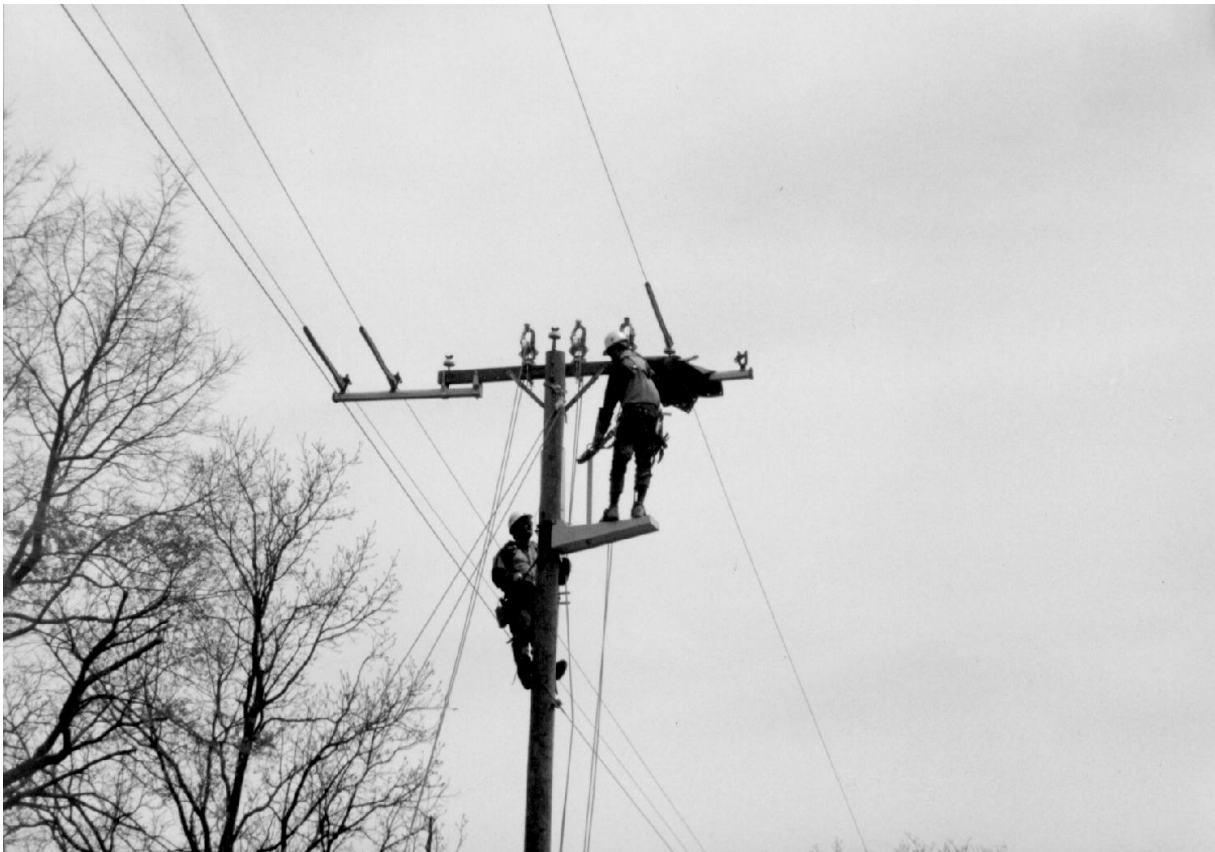
Рис. 3.13. Робота під напругою із застосуванням ізолювальної площадки
