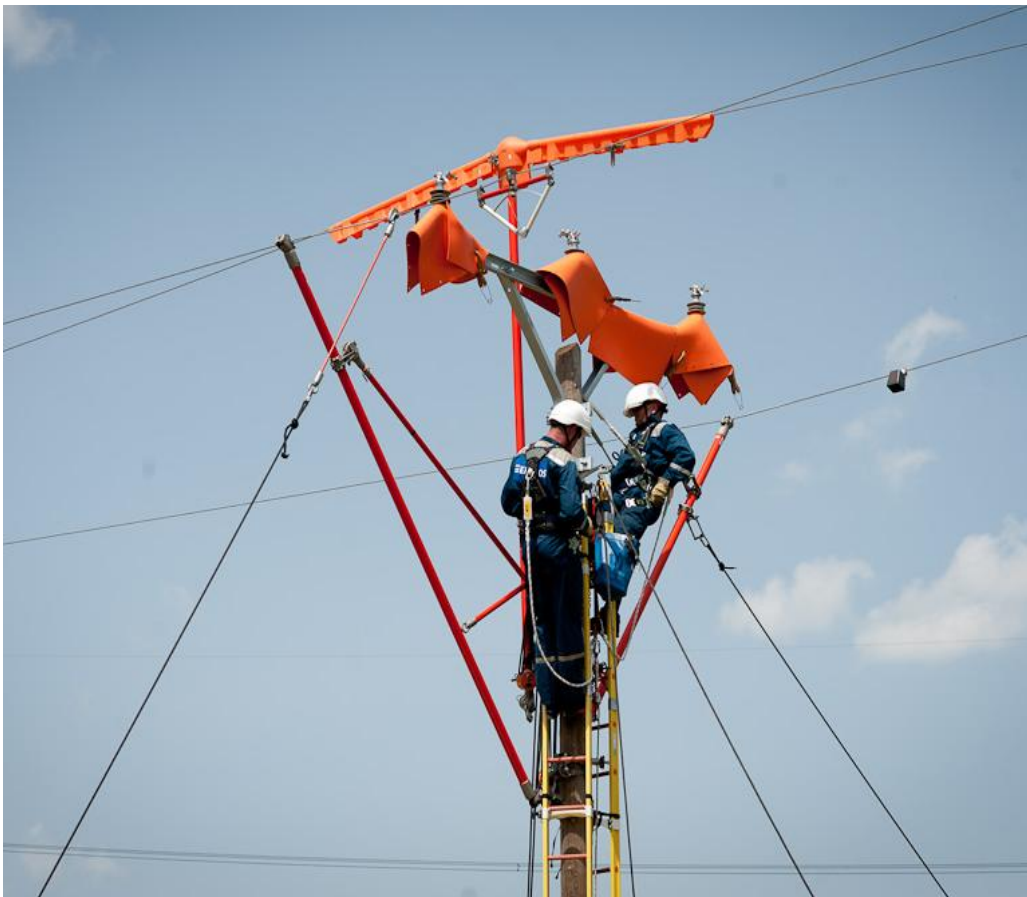
Рис. 3.18. Робота електромонтерів на ПЛ 20 кВ, що перебуває під робочою напругою
