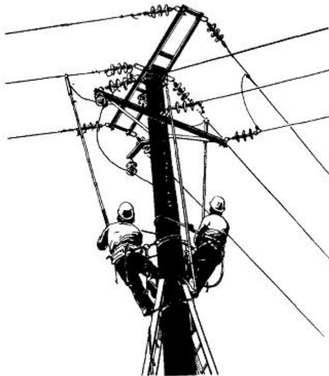
Рис. 3.17. Ремонт роз'єднувача на опорі ПЛ 35 кВ
