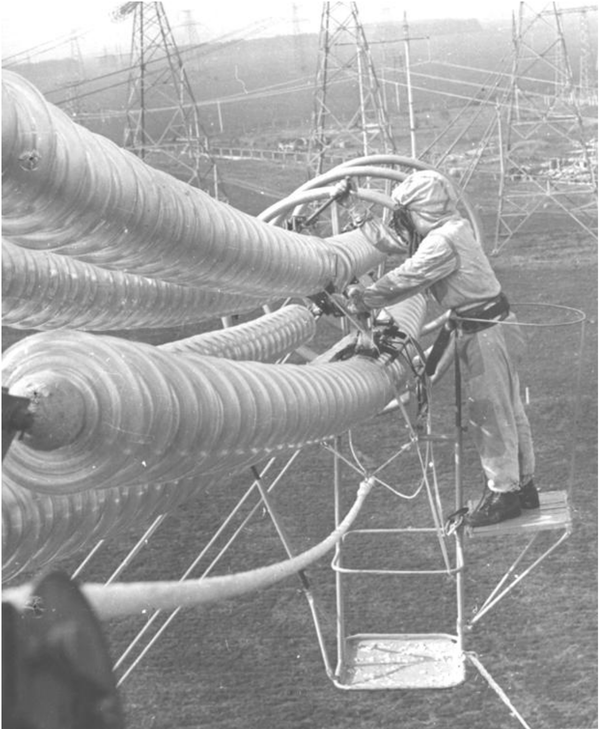
Рис. 4.23. Виконання робіт під напругою на натяжній гірлянді ПЛ 750 кВ
