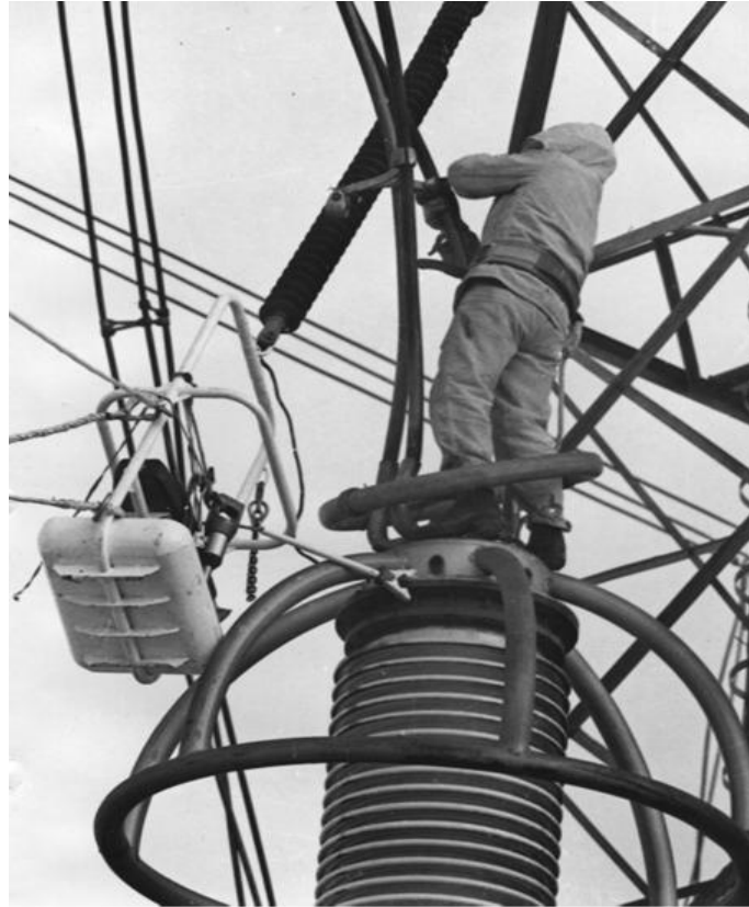
Рис. 4.39. Доставляння електромонтера на трансформатор напруги за допомогою візка
