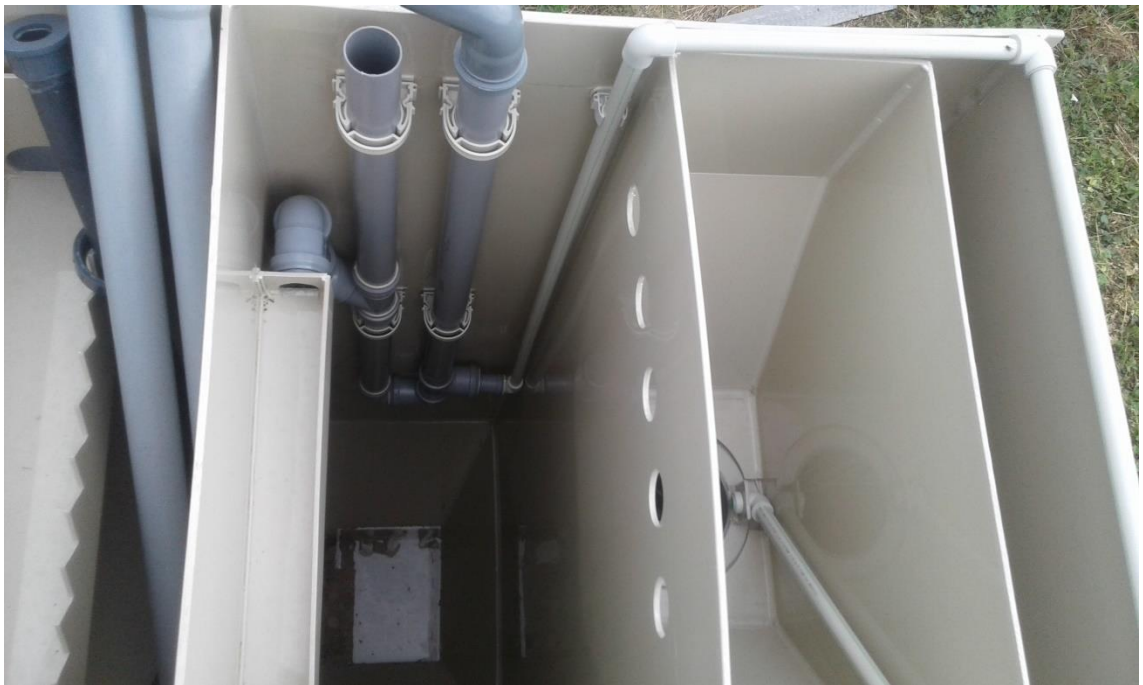
Рисунок 2.5. – Відстійник дослідної установки.
