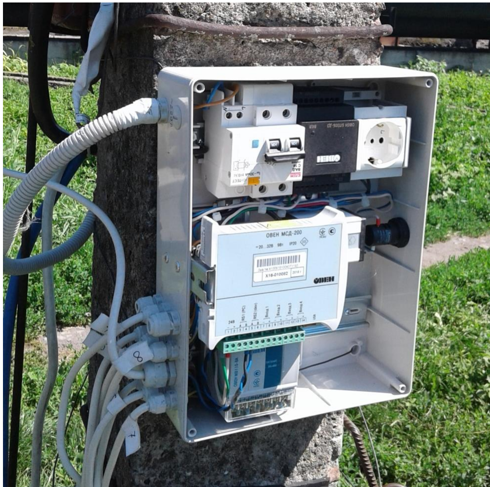
Рисунок 2.7. – Система автоматизованого вимірювання температури середовища.
