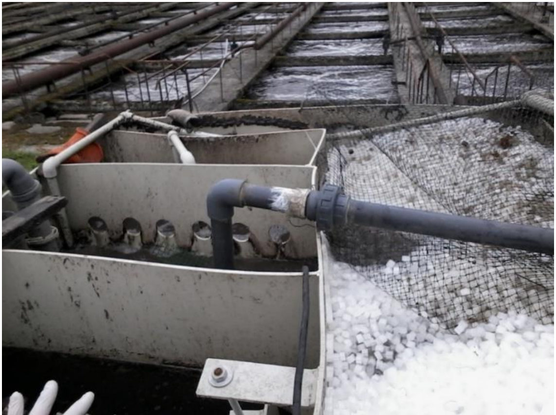
Рисунок 2.8. – Процес завантаження носіїв у реактор №2.
