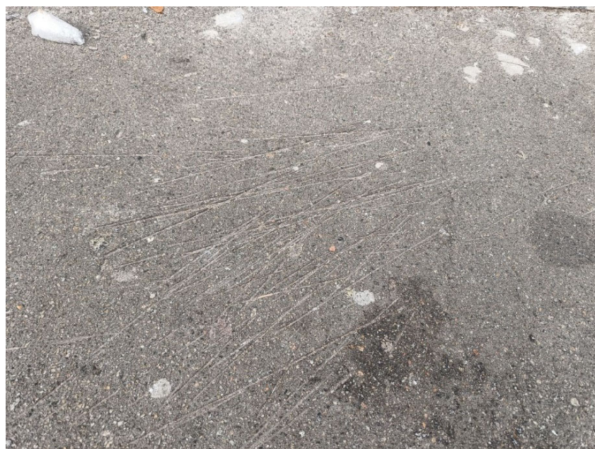
Рисунок 1.4 – Деформоване покриття.
