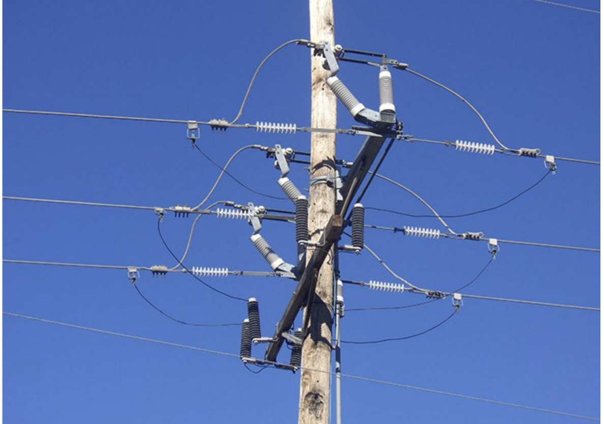
Рисунок 1.5 – Секціоналайзери у використанні
