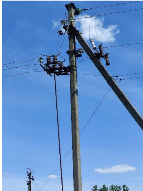
Рисунок 1.1 – Опора ПЛ 10 кВ з роз'єднувачом 10 кВ
