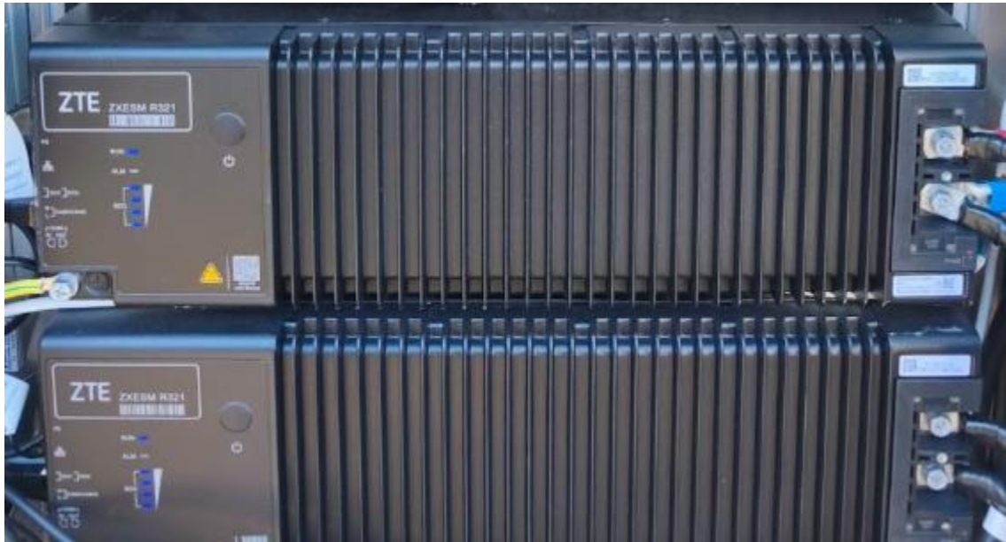
Рис 2.3 – батарейні модулі 48В,100А/год ZXESM R321 фірми ZTE встановлені на вузлі зв'язку одного з комерційних операторів України. В нових ревізіях виробник застосовує примусовий підігрів акумуляторних комірок за умови роботи на заряд при температурах середовища наближених до нуля, та нижче нуля.
