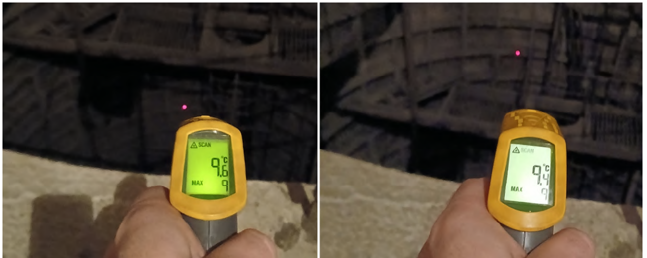
Рис.1.5. Заміри температури оболонки вентшахти за допомогою пірометра.
