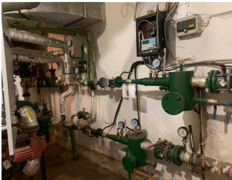
Рисунок 2.3 – Зображення приєднання ІТП до тепломережі
