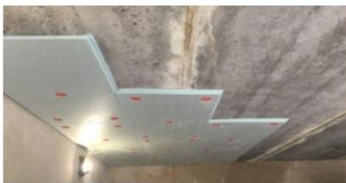
Рисунок 3.4 – Приклад утеплення перекриття підлоги
