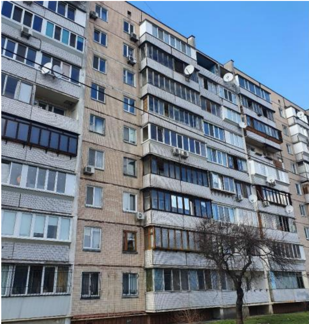
Рисунок 1.1 – Зовнішній фасад будівлі
