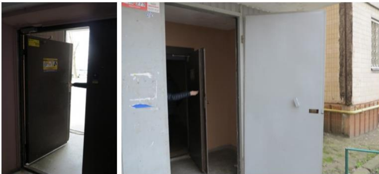
Рисунок 1.3 – Вхідні двері будівлі
