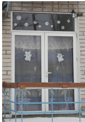
Рисунок 2.5 – Зовнішній вигляд вхідних дверей будівлі
