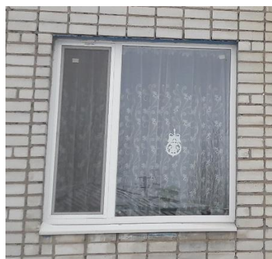
Рисунок 2.3 – Зовнішній вигляд одного з вікон будівлі
