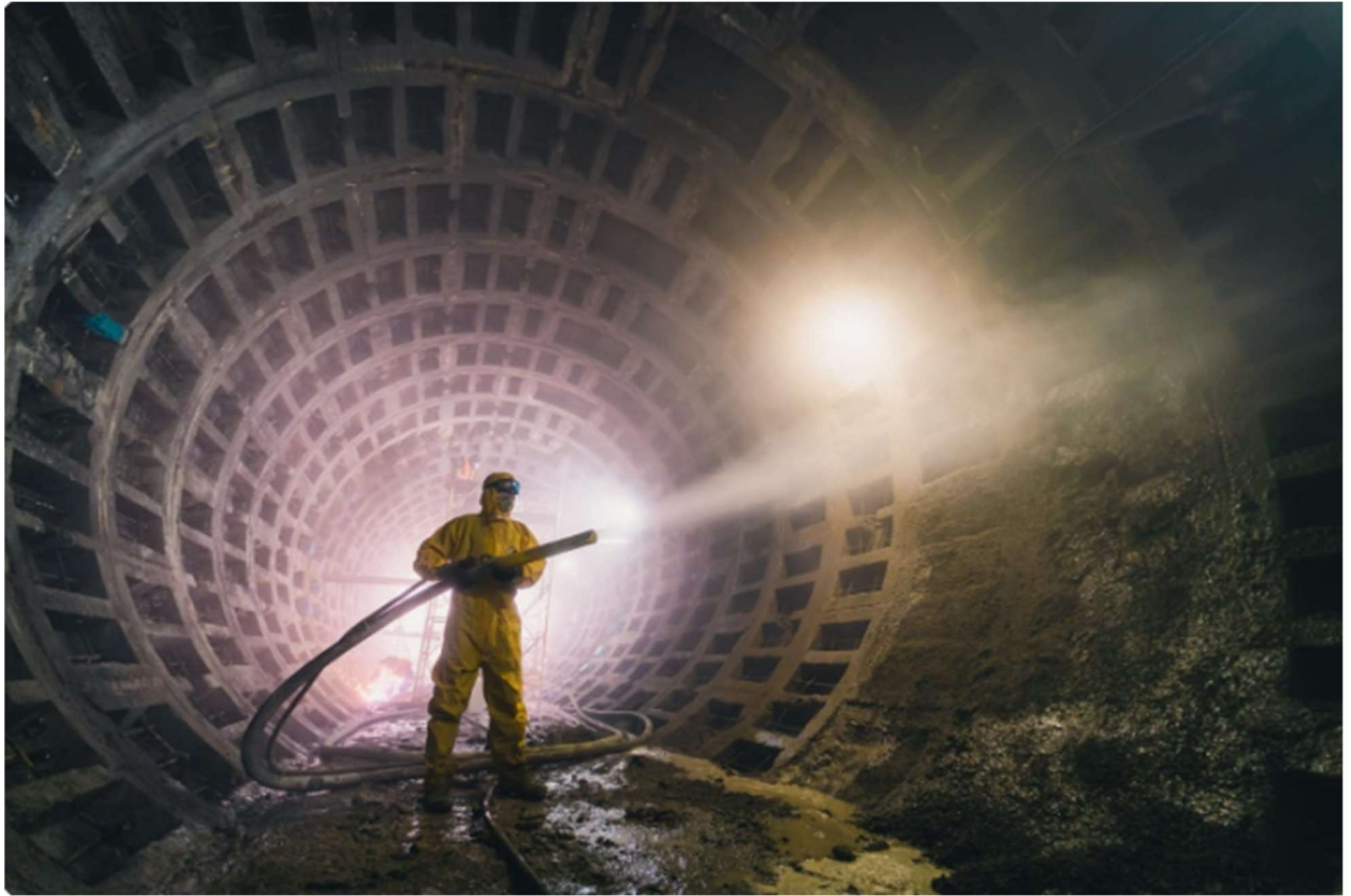
Рисунок 3.5 – Нанесення «набриск-бетону» на тунельну оправу тунелю [25]
