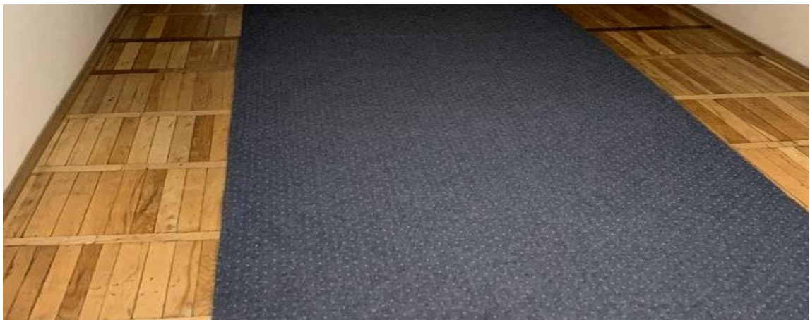
Рисунок 3.7 – Ламінат у нежитловій будівлі
