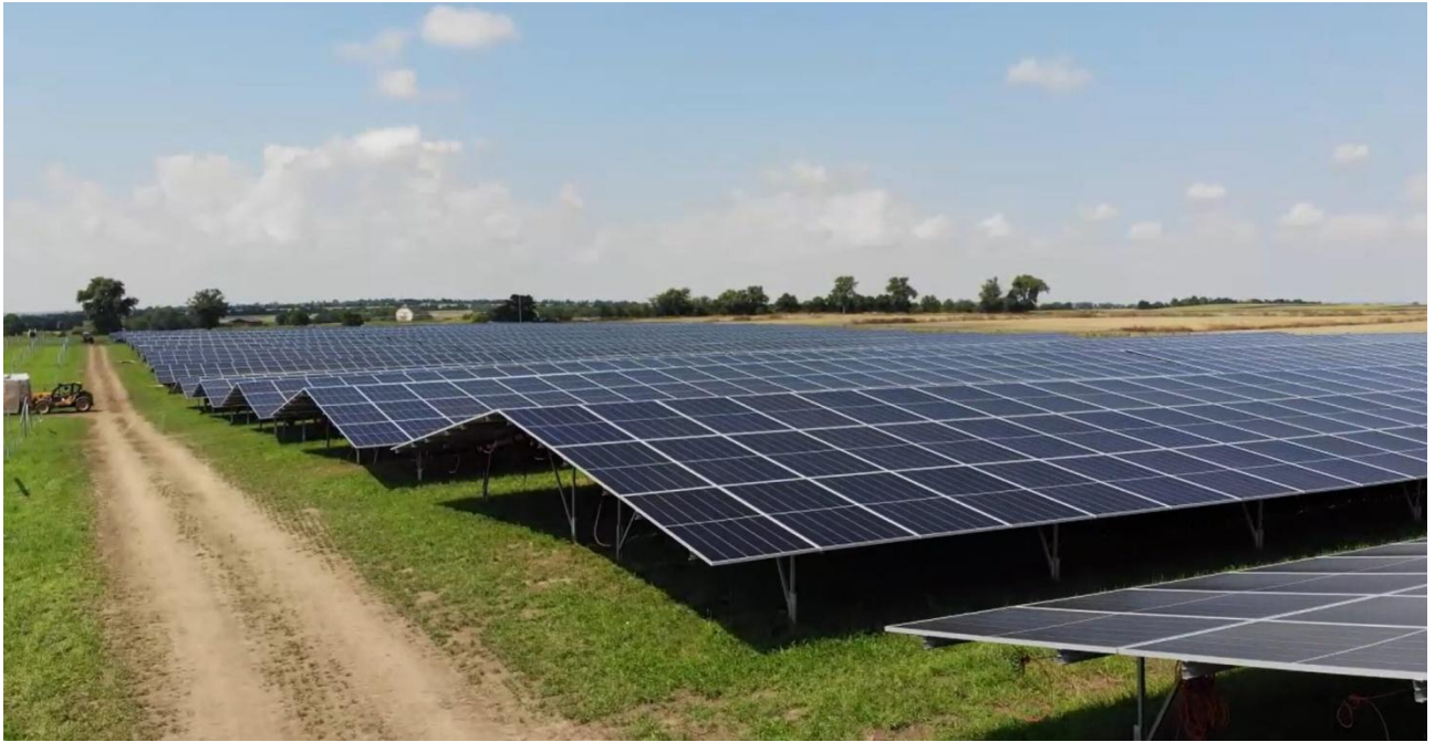
Рисунок 2.8 – Конструкція наземного кріплення фотомодулів SolarSK
