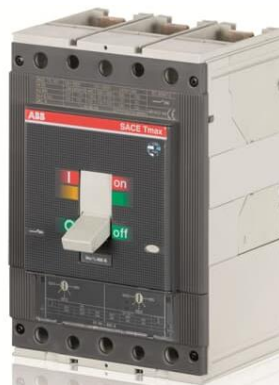
Рисунок 3.4 – Автоматичний вимикач АВВ Т5N 630 ТМА 500-5000
