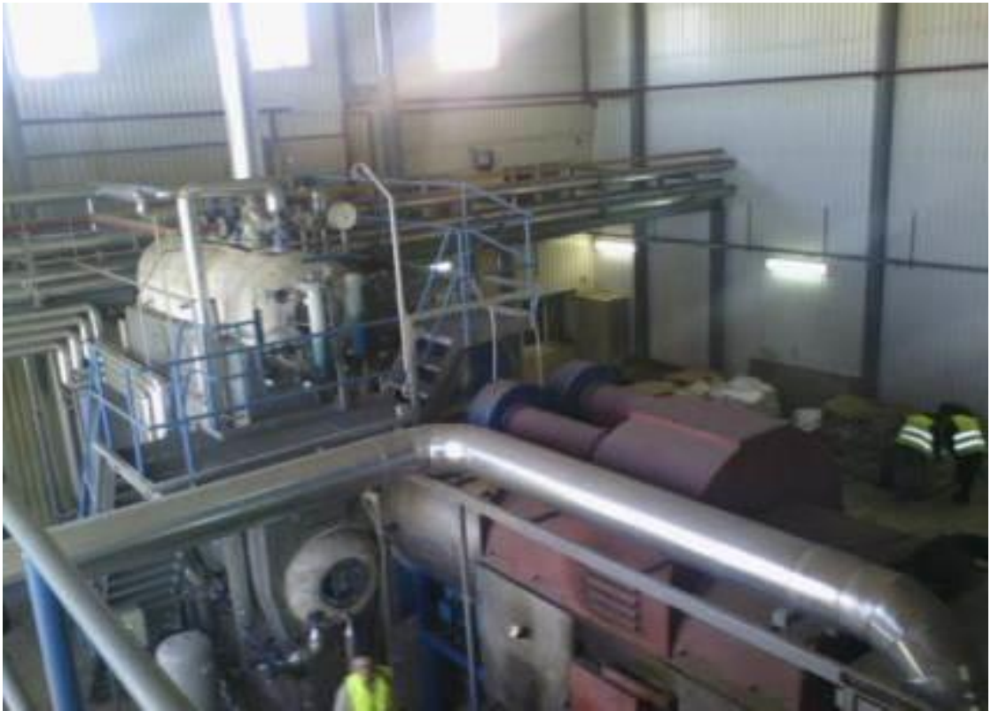
Рисунок 3.2 - Твердопаливний котел ДЕ-6,5-14
