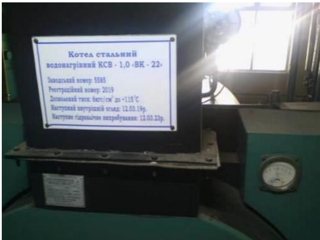
Рисунок 3.3 - Котел КСВ-1 водогрійний газовий 1 МВт
