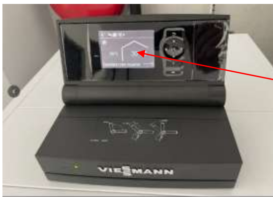
Рисунок 5.2. Регулятор теплового насосу на екрані в режимі «standby»
